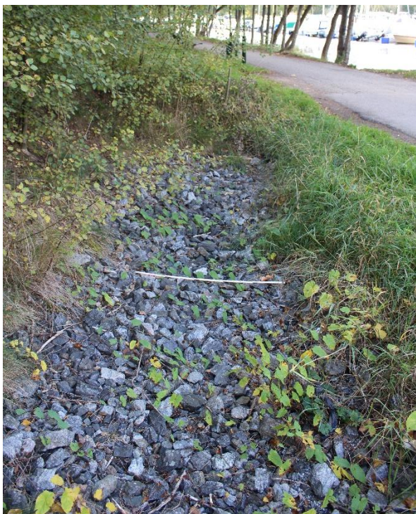
Figur 19. Befintligt makadamdike (platsbesök 2021-09-22). Måttstock ca 1 m för referens.
