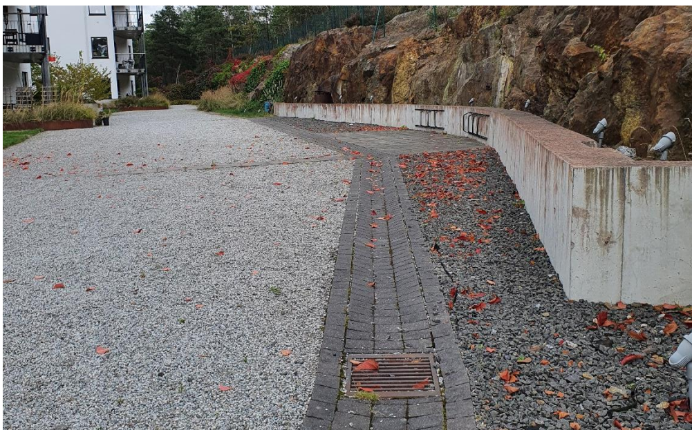
Figur 13. Rännan med brunnar, vilken löper längs den södra fastighetsgränsen (Eolshällsverket).
