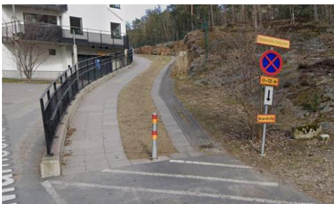
Figur 14. Rännan för dagvatten, med brunn där rännan avslutas vid Mamsell Ullas väg.
