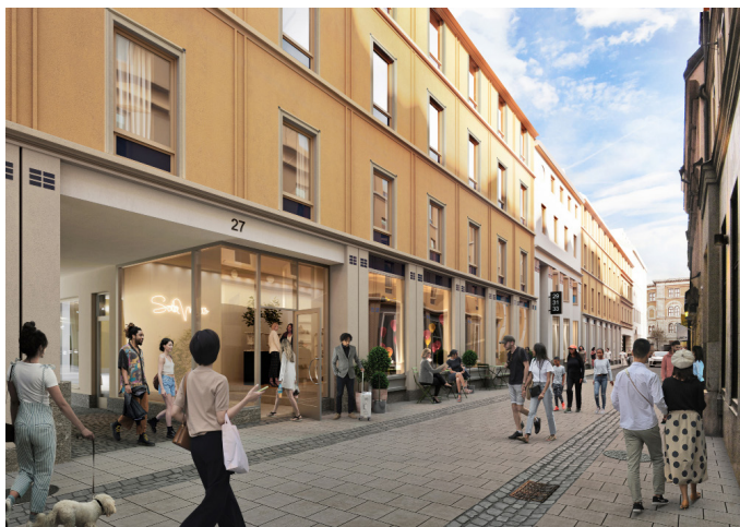
1. Vy från Klara Norra Kyrkogata med ny glasbox och sänkt bröstning på befintliga fönsteröppningar. Portikens undersida får putsad yta lika fasad.
