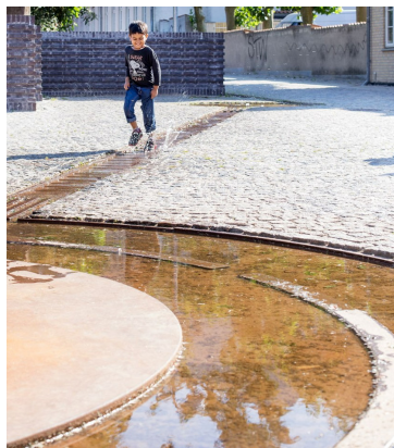
Referens på låg dagvattendamm
