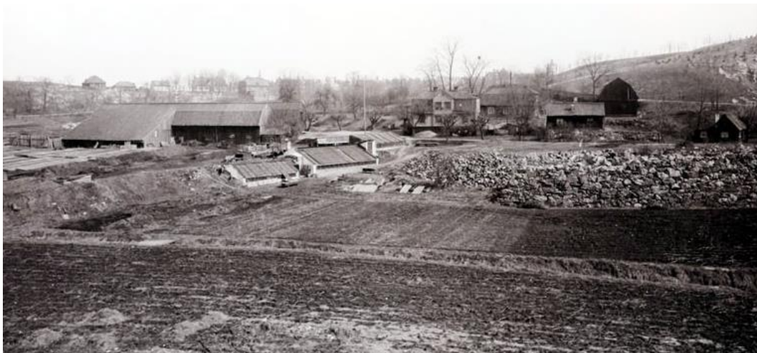
Figur 3. Fotografi från 1904, taget från väster. Det större avlånga trähuset (ladan) till vänster motsvarar ungefär mitten av dagens Svearondell. Villahuset ungefär i mitten av bilden är Cederdals malmgård som står kvar även idag som en blåklassad byggnad. Observera att ladan och de andra byggnaderna närmare fotografen ligger på lägre höjd än villahuset. Jämför med Figur 5. CC-BY Larssons Ateljé 1904-04-15, källa: https://stockholmskallan.stockholm.se/post/1185 .
