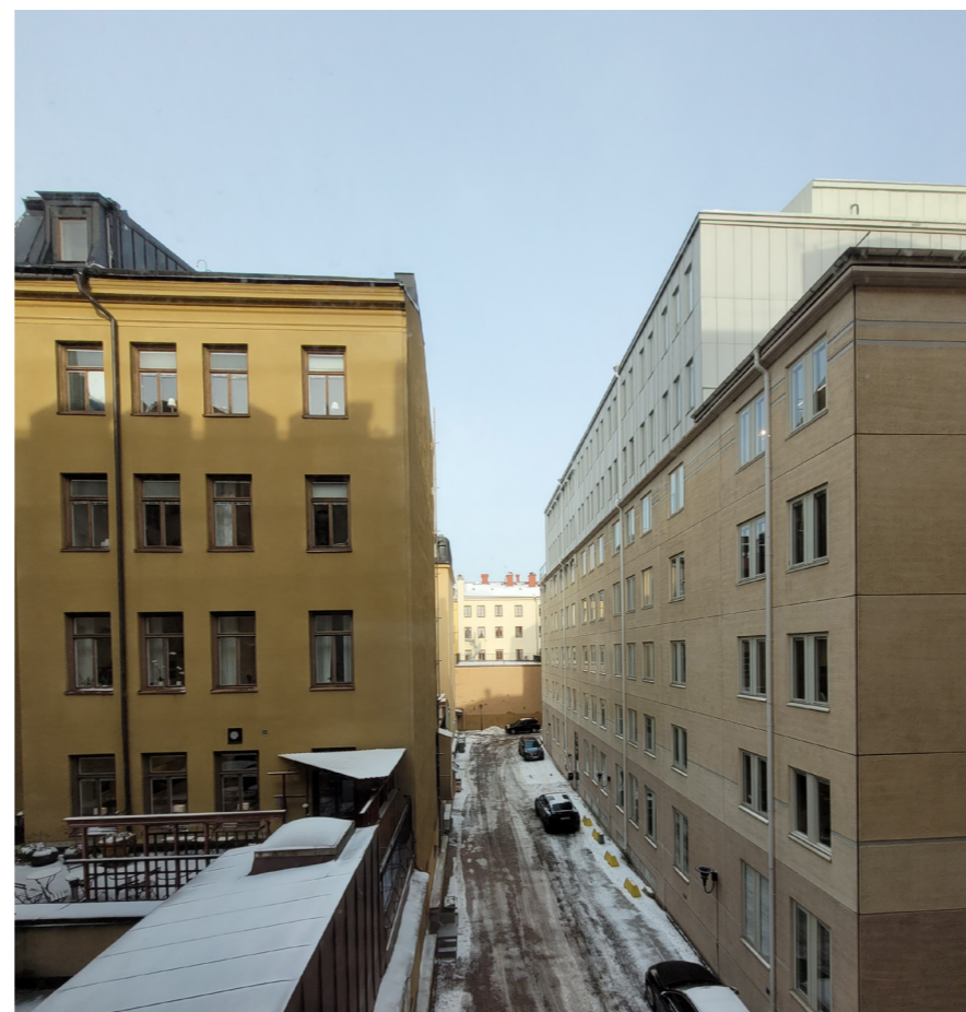
Den del där fönstren föreslås utvidgas i takvåningarna är fasaden mot väster.
