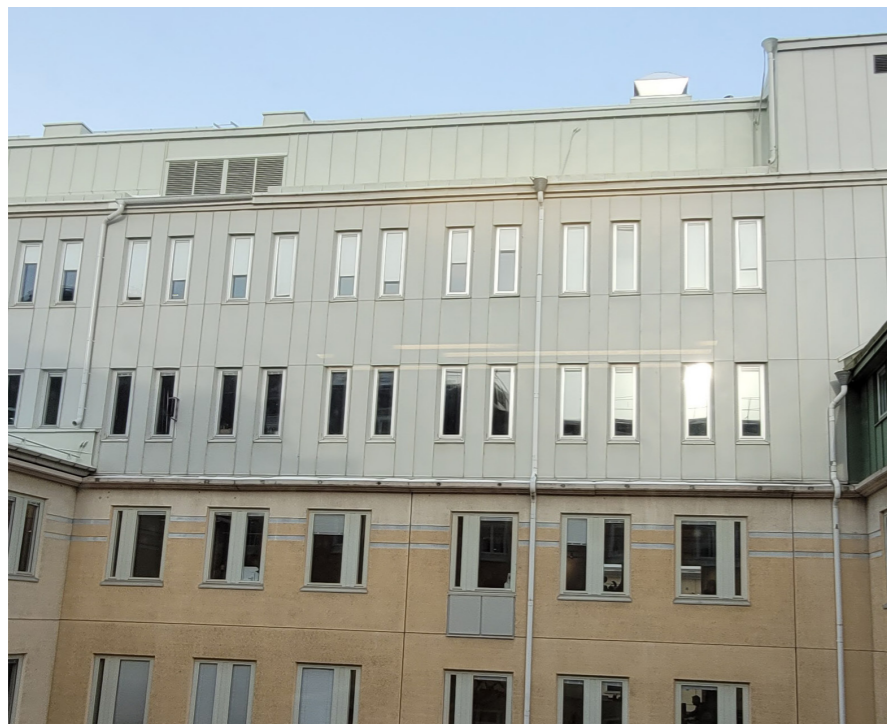
De parställda smala fönstren i takvåningarna ger brister i arbetsmiljön och föreslås ersättas av större sammanslagna fönsteröppningar i del mot väster. Bilden visar fasader mot söder.
