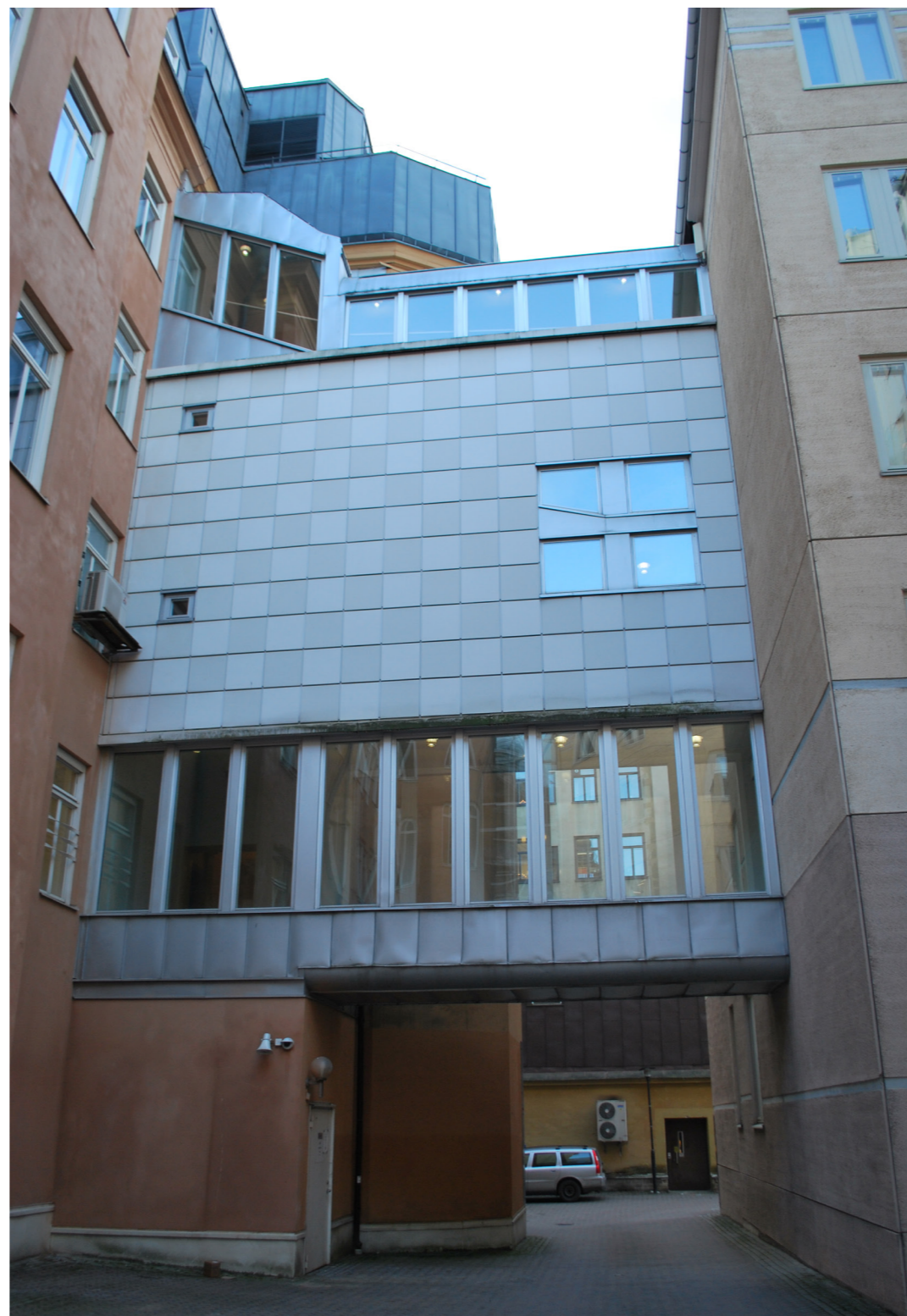
Befintlig förbindelsegång från 1980-talet föreslås rivas för att kunna ersättas med en bättre fungerande länk mellan Lagern 14 (till vänster) och Lagern 11 (till höger).
