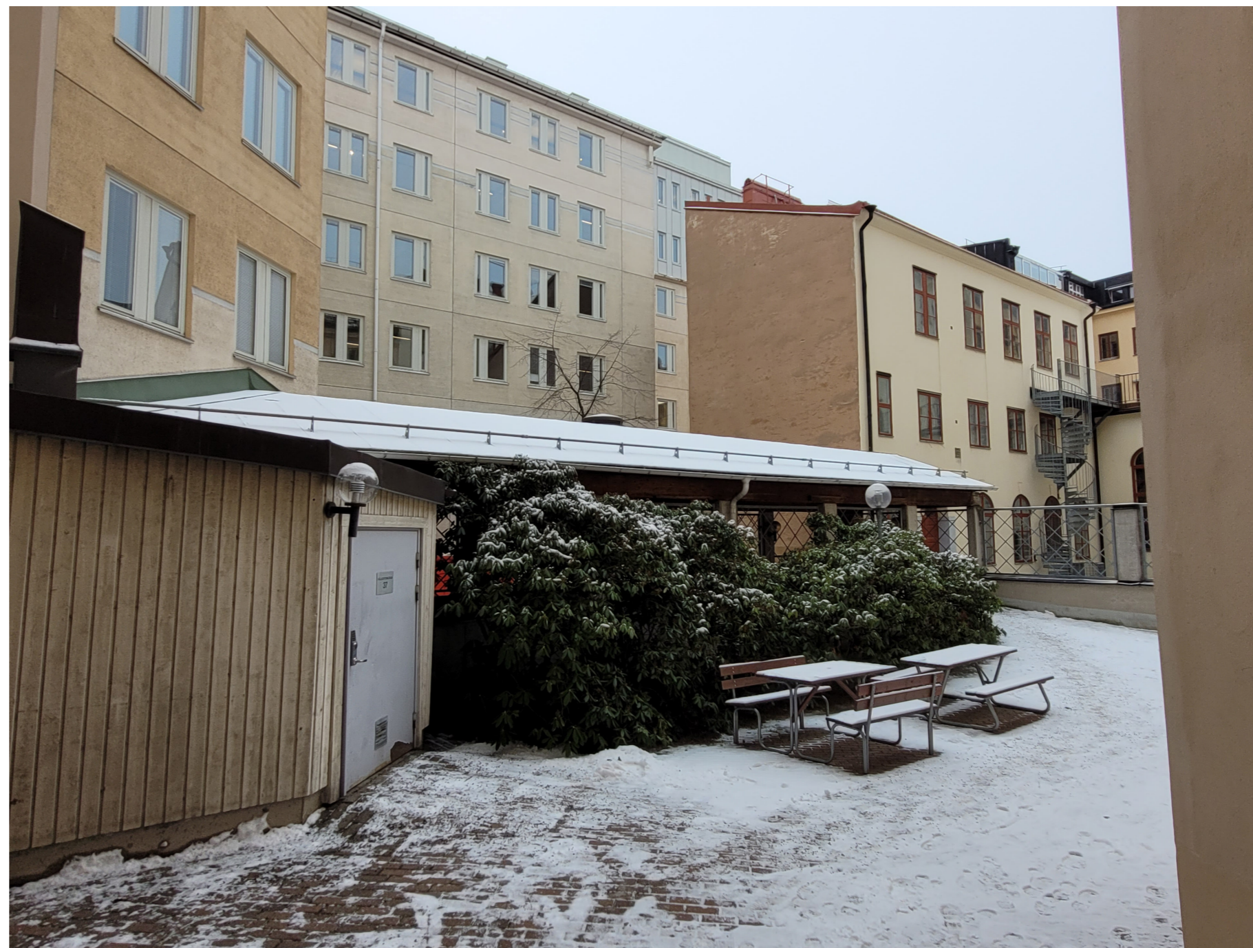
Befintlig soprumsbyggnad på gården till Lagern 15.
