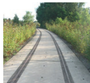
Gjutna järnvägsspår – (Bild: Nivå, 2022).
