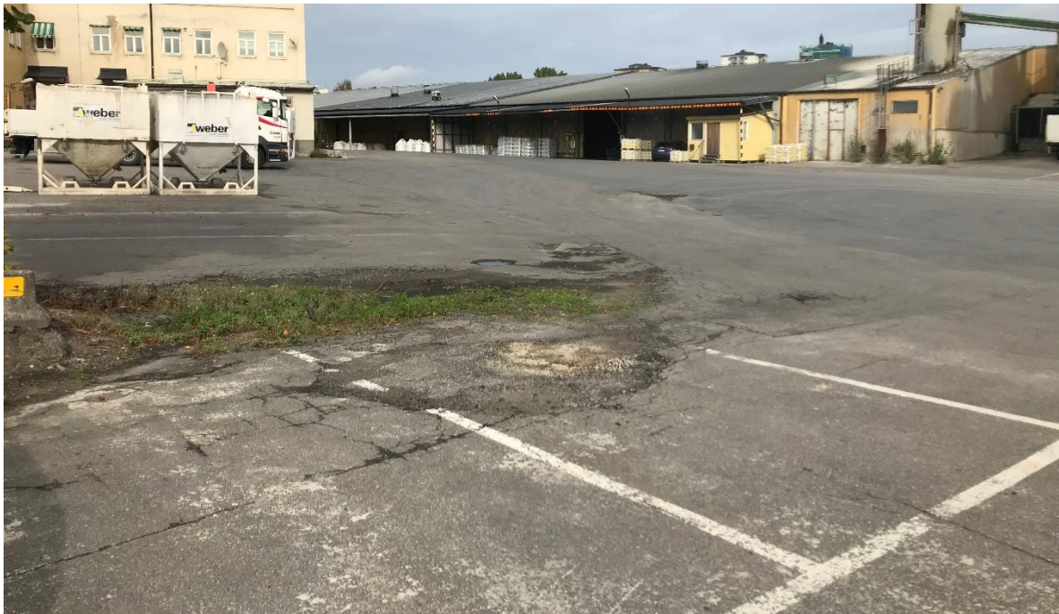
Figur 2-3. Bild från platsbesök 2018-09-11.
