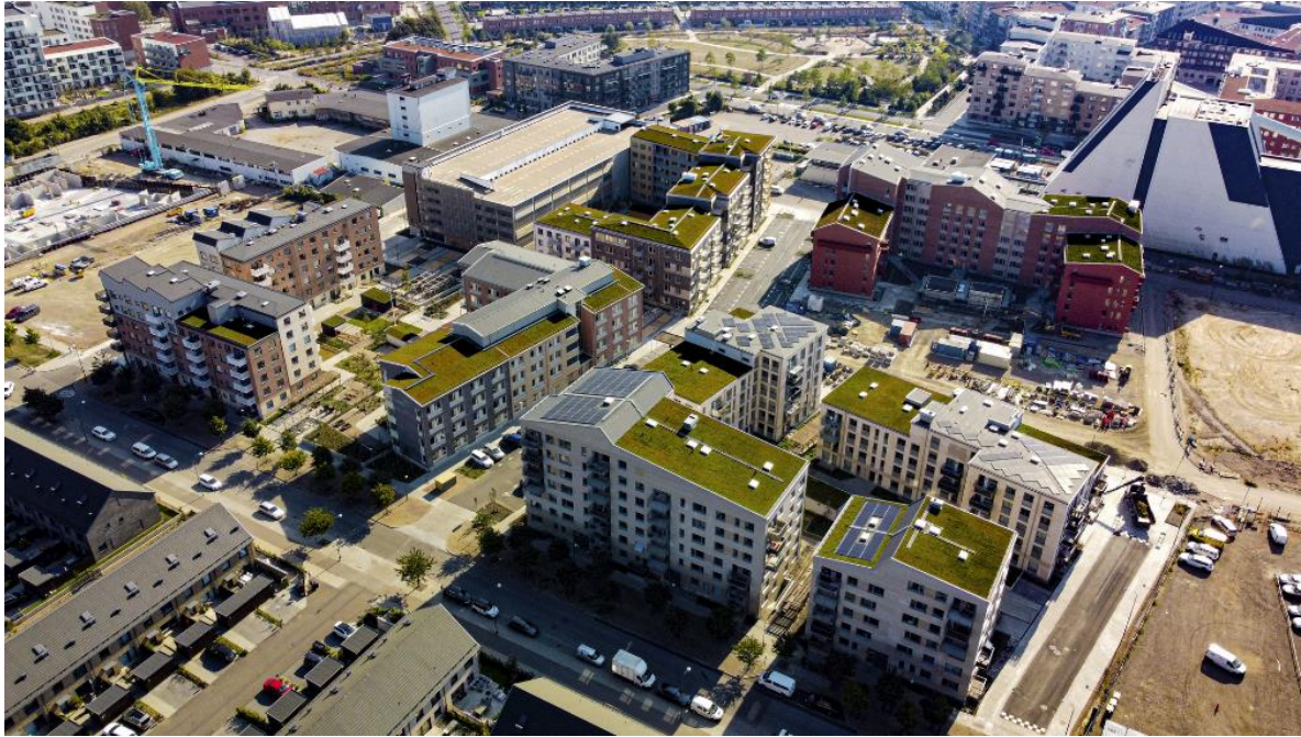
Figur 6-1. Exempelbild på gröna tak i stadsmiljö. Källa: Byggnyheter 19
