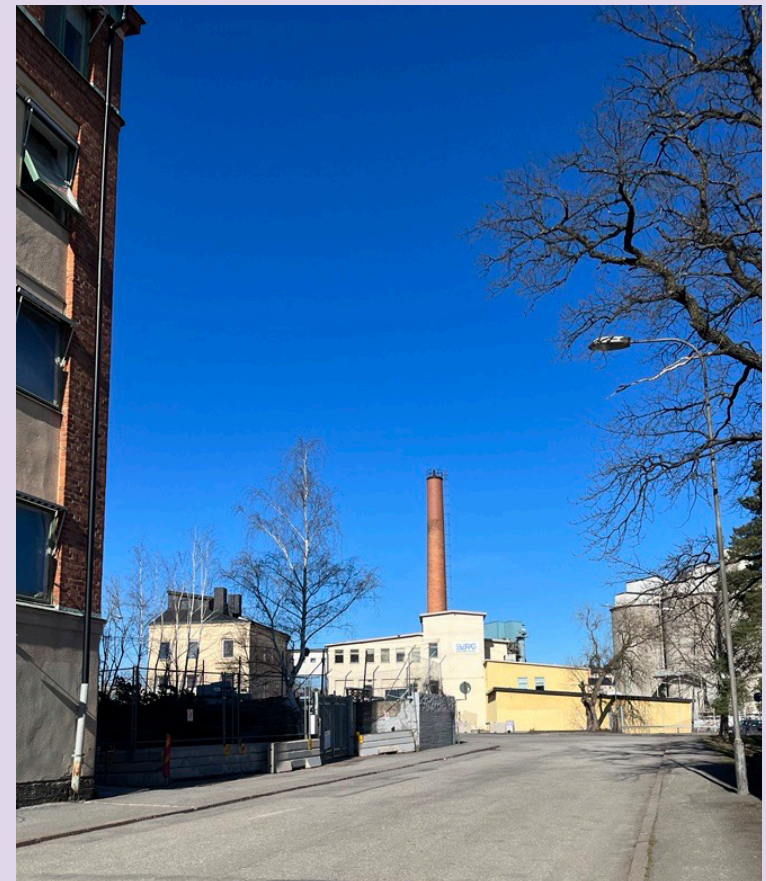
FOTO: INDUSTRIBYGGNADER I LÖVHOLMEN, WSP
