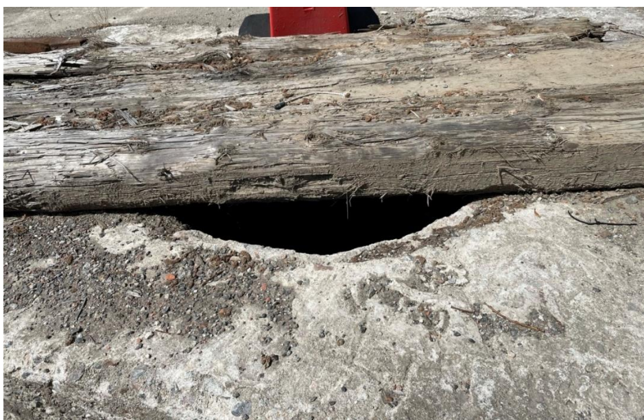
Bild 8, Håltagningar på Beckerskajen
