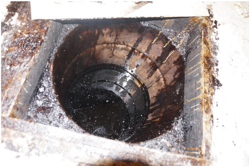
Figur 2. Uppsamlingsbrunn, på upphöjd del i den djupare källaren, med inflödade avfallsolja (foto från februari 2022).
