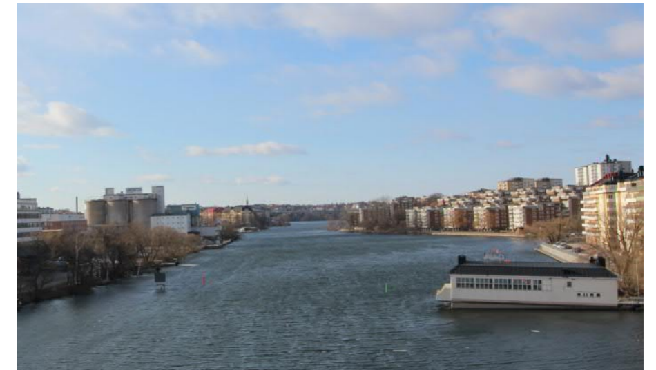
Vy över Liljeholmsviken sedd från öster, mars 2019. Lövholmens industribebyggelse finns kvar men bebyggelsefronten på Reimersholme har förändrats när fabriksbyggnader rivits och ersatts med bostadsbebyggelse. Bergsunds strands front mot vattnet är i princip densamma som föregående foto.
