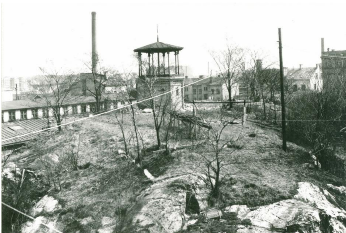
Bergsknallen invid Palmcrantzka fabriken under 1930-talet innan utgrävningsarbetena startade. Stadsmuseet.
