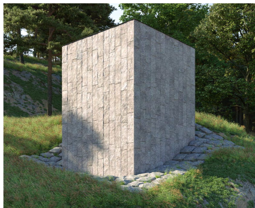
70: Luftutbytesschakt i Järla med fasad av natursten.
