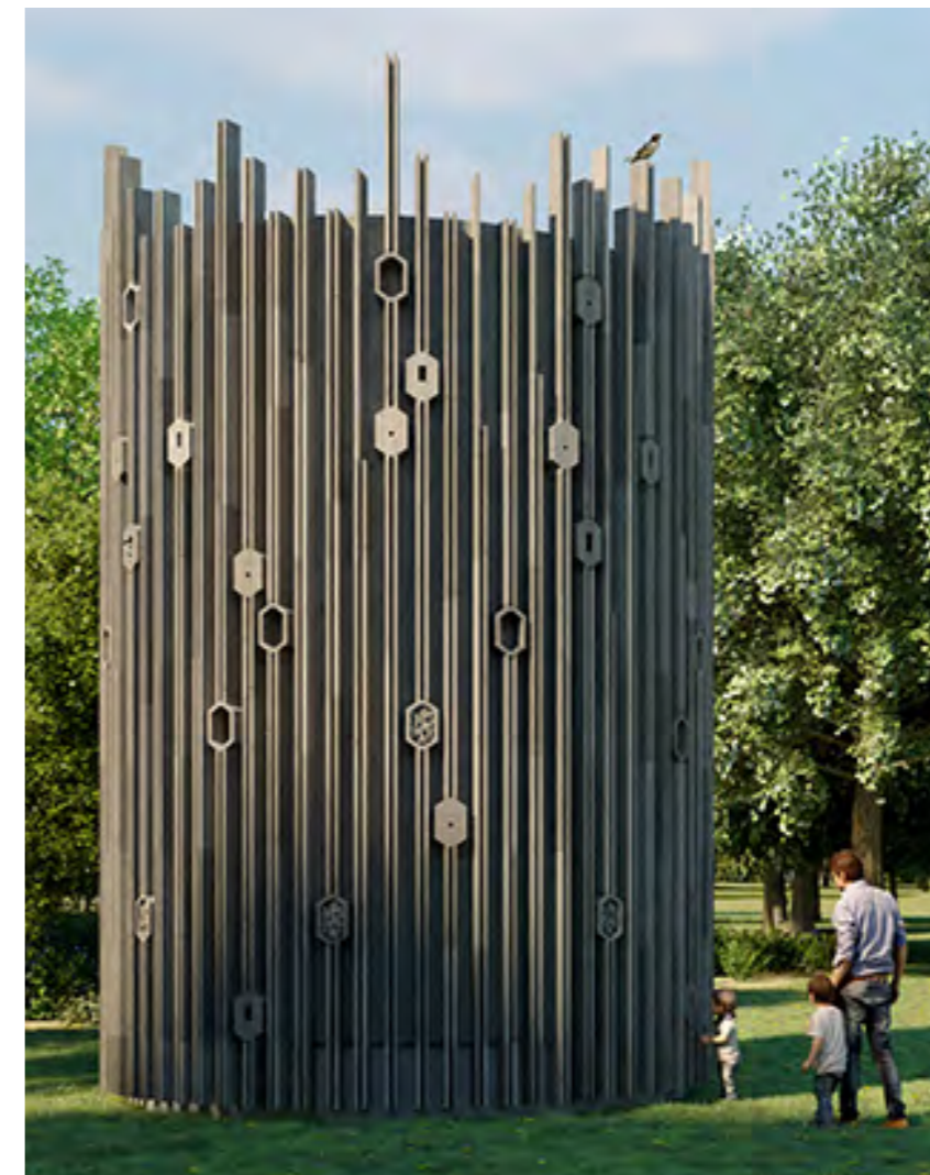
71: Luftutbytesschakt i Koleraparken med insektshotell i träfasaden.
