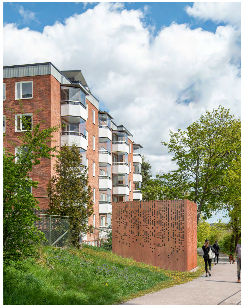
69: Luftutbytesschakt i Sickla med fasad av perforerat corténstål.
