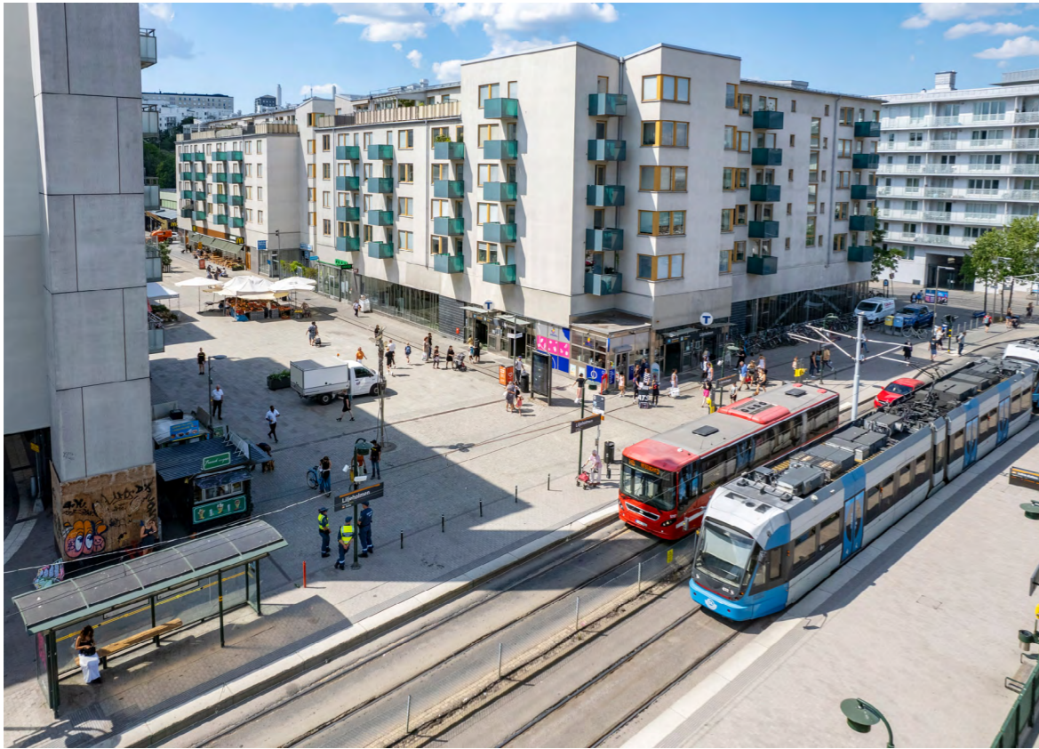
39: Liljeholmstorget och en av de befintliga entréerna till tunnelbanans Röda linje.
