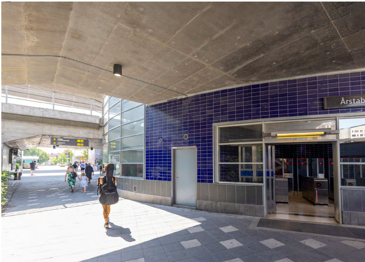
46: Entrén till pendeltågsstationen under broarna.
