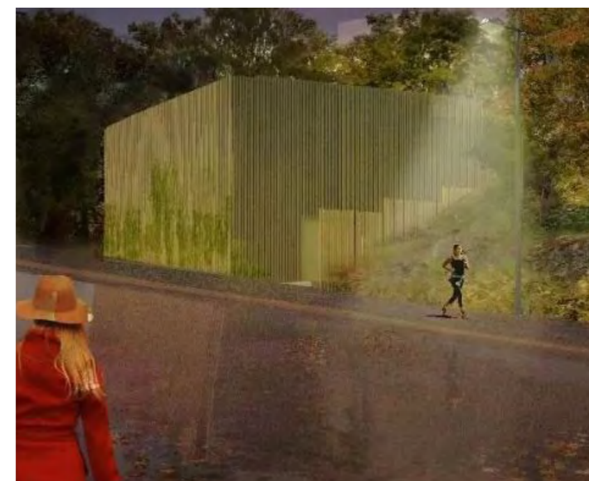
72: Likriktarstation i Stadshagen med fasad av träribbor.
