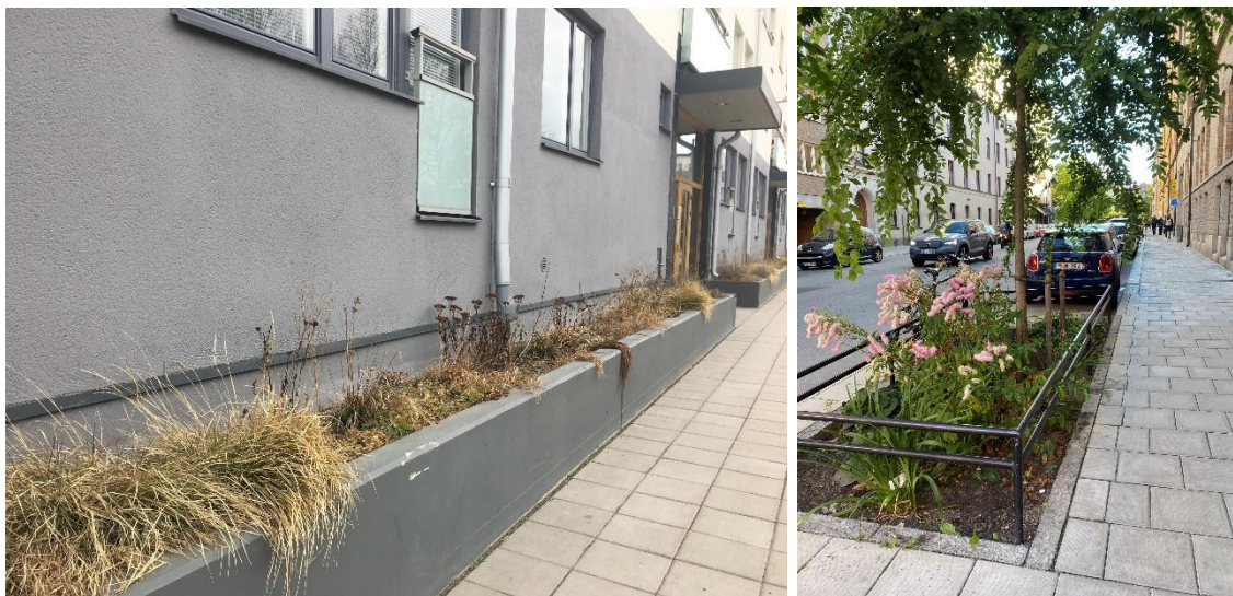
Figur 18. Exempel på upphöjd växtbädd längs med fasad (t.v) och nedsänkt växtbädd (t.h) (Foto Bjerking).
