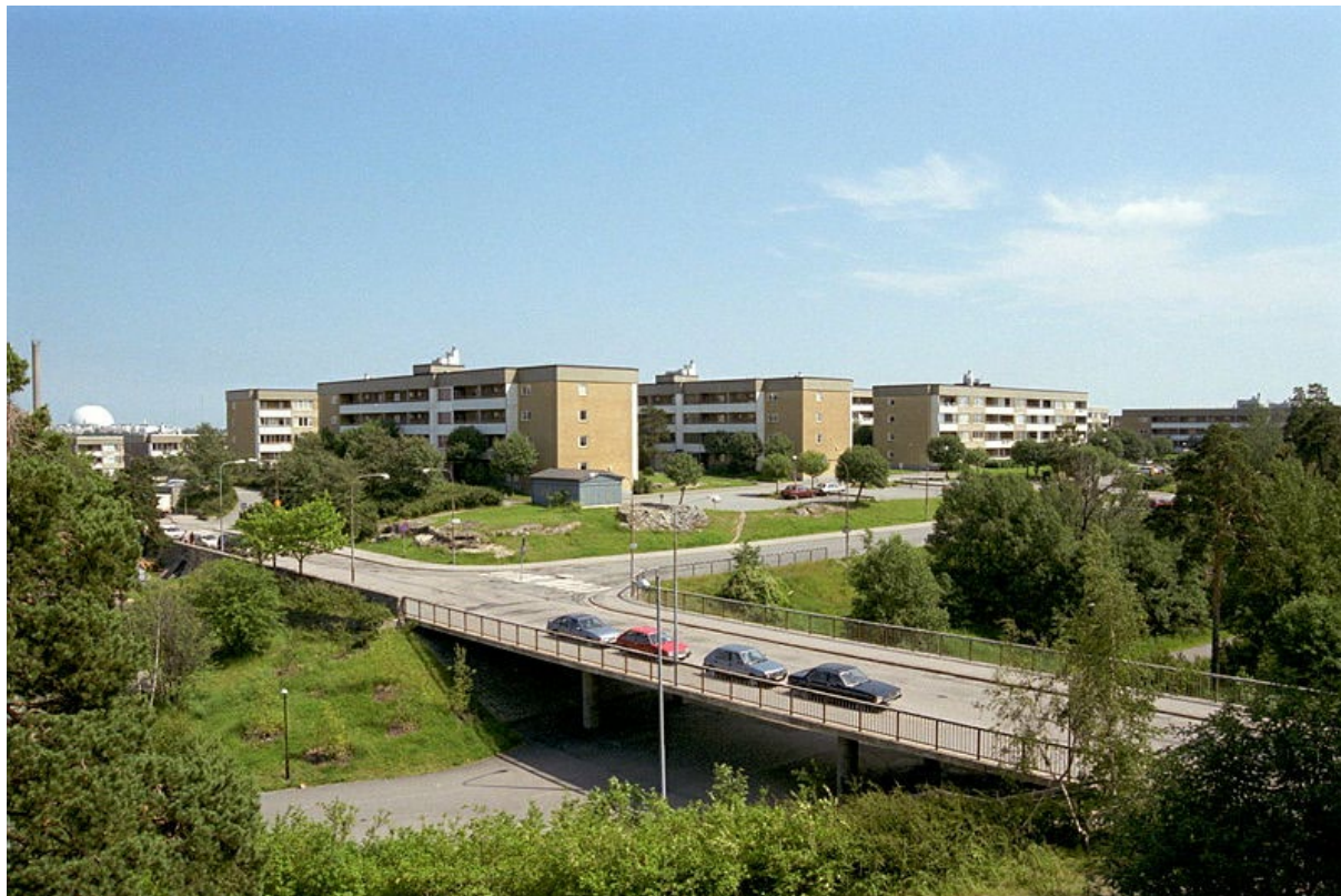
Figur 23. Vy från nordväst över viadukten vid Östbergabackarna mot kvarteret Spinnsidan. I fonden till vänster skymtar Globen. Foto från 1997. Källa: Stockholms stadsmuseum.
