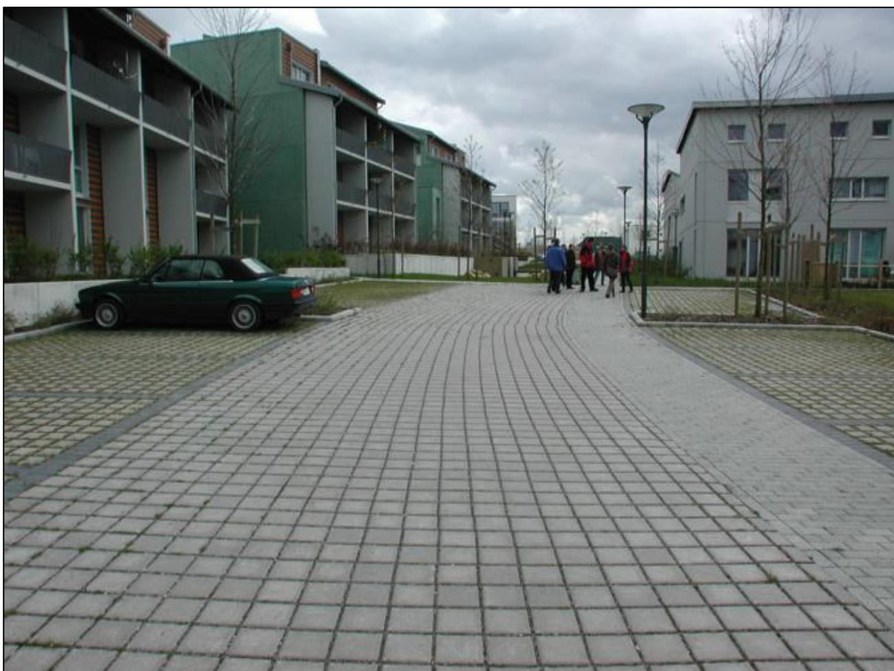
Figur 7-5. Parkering och gata med genomsläpplig beläggning (Foto: Norconsult).
