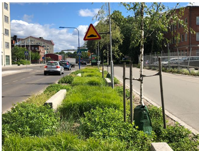
Figur 12. Exempel på utförande av regnväxtbädd.
