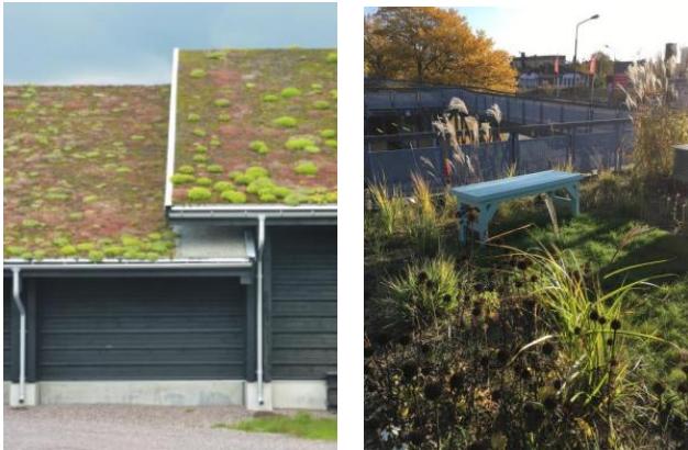
Figur 14. Exempelbilder på tunt grönt tak (till vänster) och tjockt grönt tak (till höger)
