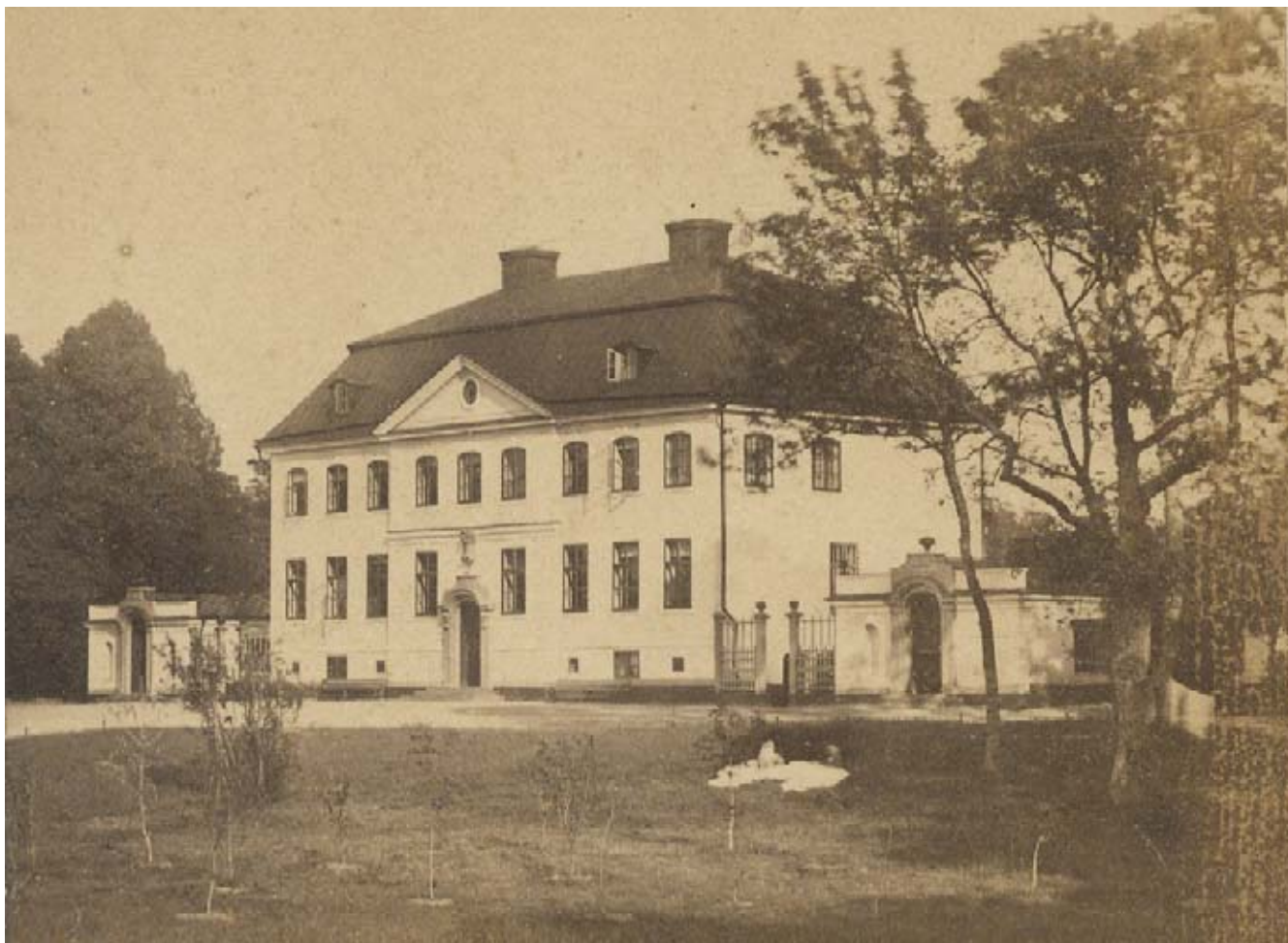
Det äldsta kända fotot av Kristinebergs huvudbyggnad med paviljonger, taget tidigt 1860-tal från gårdsplanen och med huvudbyggnadens exteriör förhållandevis orörd sedan uppförandet. Äldre källor uppges att frontonen skulle ha varit ”rikt ornerad samt av huggen sten”, något som inte är bevarat vid tiden för fotot. Fotograf okänd, F 97867, SSM:s arkiv.
