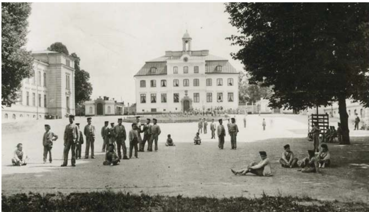
Barnhusbarnen ute på gårdsplanen, 1900-talets början. I samband med tillbyggnader för Frimurarbarnhuset byggdes huvudbyggnadens framspringande risalit på med en tre fönsteraxlar bred attika. I attikans bågformiga avslut insattes ett urverk. Taket kröntes med ett lanterninliknande klocktorn. Framför byggnaden har idén med en gräsklädd rundel bevarats från 1700-talet. Okänd fotograf, F52165 SSM:s arkiv.
