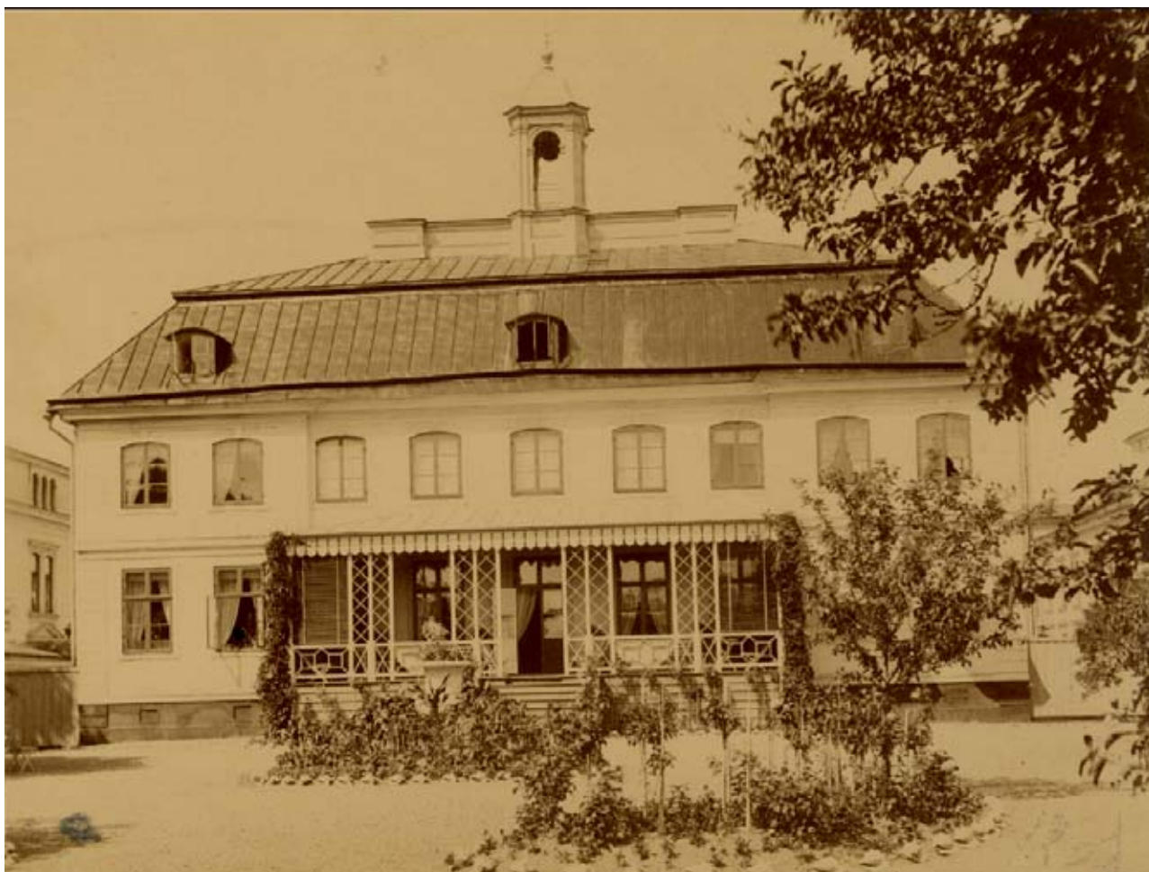
Huvudbyggnadens fasad mot söder och parken, med verandan från 1860-talets mitt. Foto omkring 1888, fotografokänd, Fa 5627, SSM:s arkiv.
