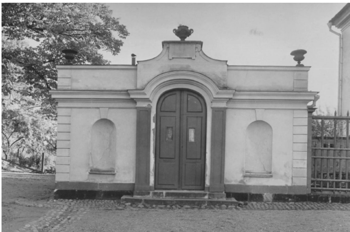
Östra paviljongens fasad mot norr år 1923. Paviljongerna uppfördes 1842 - 1843. Fasadens avslutande attika med krönande urnor döljer ett flackt sadeltak. Ursprungligen satt inga portar i den välvda portalen, utrymmet innanför, med kalkstengolv och limfärgsmålade väggar, stod öppet och benämndes lusthus. På fotot är portalens pilastrar målade, men på fotografiet från 1860-talet i det följande tycks hela portalen, med arkivolt och förhöjd del av attikan, vara enhetligt målade. Foto Gösta Selling, Samfundet Sankt Eriks samling, SSM:s arkiv.
