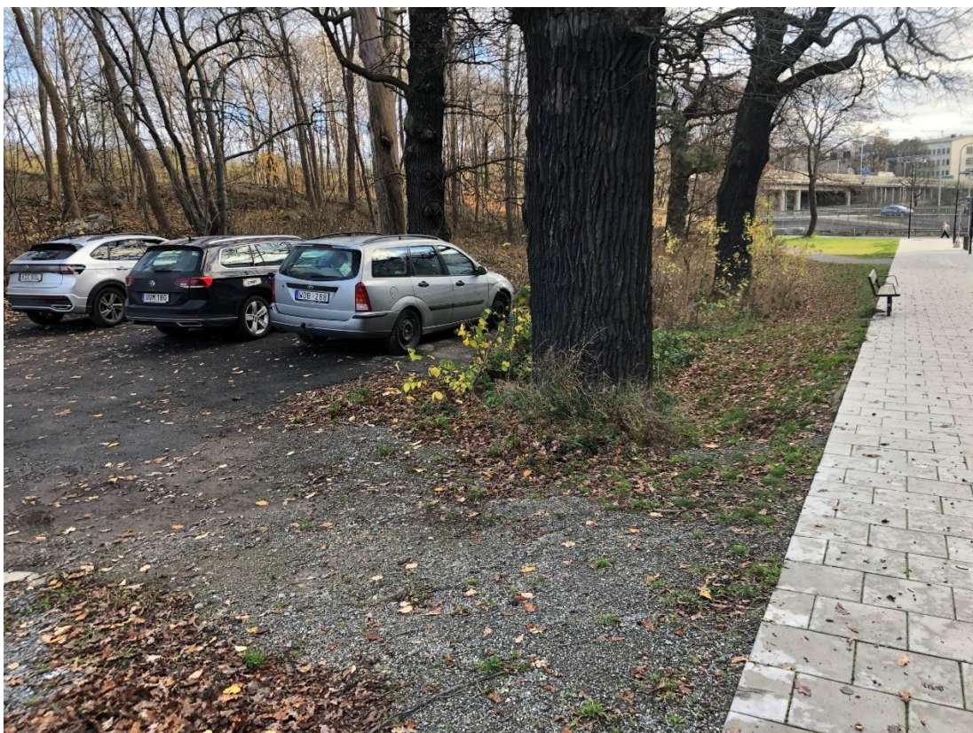
Bild 6. Uppfylld mar kring träden rekommenderas till att tas bort och överbyggnad till nya hårdgjorda beläggningar ska bestå av sk rotvänligt förstärkningslager.
