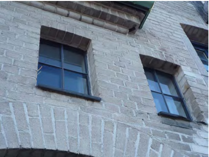
1 Stallbyggnaden med dess karaktäristiska ventilationshuvor. Den ändrade användningen syns i exteriören på de glasade lastportarna in till f.d. höskullen samt en mängd takfönster. 2 Typiska materiaverkan; grått tegel och mörkgrå fönster med solbänkar av skiffer. De små öppningarna har ursprungliga järnfönster.
