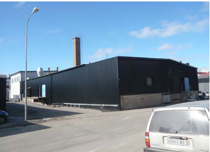
1 Nybyggnadsritning med fasader, 1954, arkitekt N. Ivar Bäckman. Källa: BNA. 2 Kontorshus i två våningar med huvudfasad mot Slakthusgatan. 3 1987 genomfördes en rad ändringar i samband med att konservfabriken byggdes om för köttantering. Lågdelens fasader tilläggsisolerades och kläddes med plåt.
