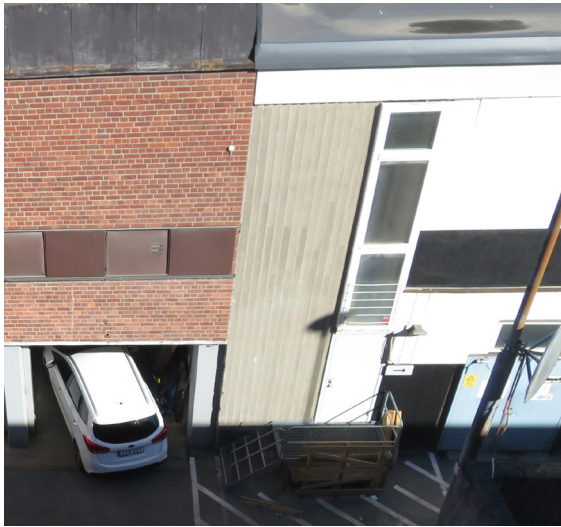
Möte mellan de två fastigheterna nr 5 och nr 6. Lägga märke till det mönstergjutna fasadavsnittet.
