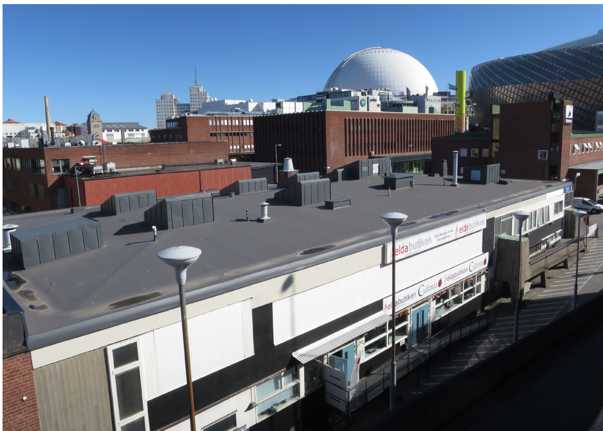
Vy från taket på Charkuteristen 8 mot Globen. Charkuteristen 6 har flera lanterniner på taket.
