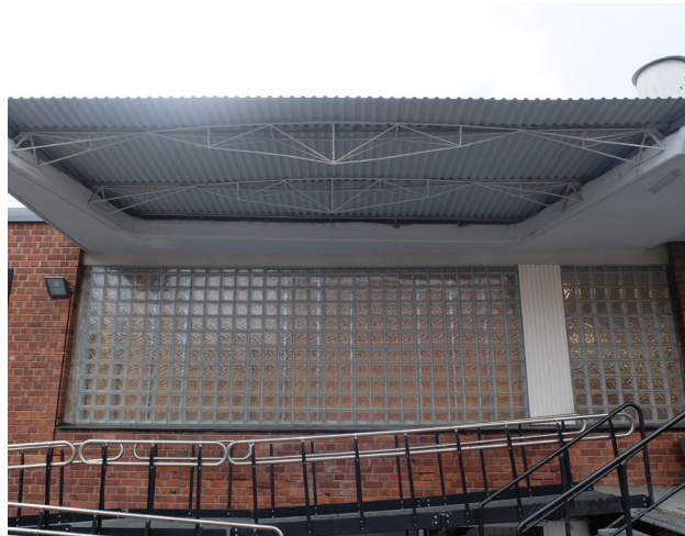
Stort fasadparti med glasblock. Ursprungligt skärmtak med betongstomme och fackverk.
