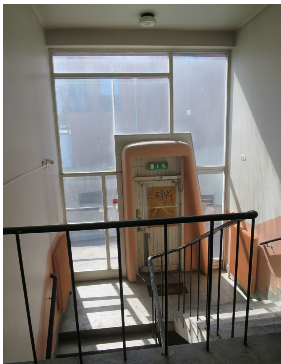
Trapphus med den invändiga portiken infogad i ett stort ursprungligt glasparti.
