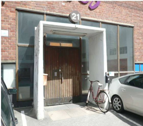
Entrépartiet på Charkuteristen 5 som leder in till kontorsdelen.
