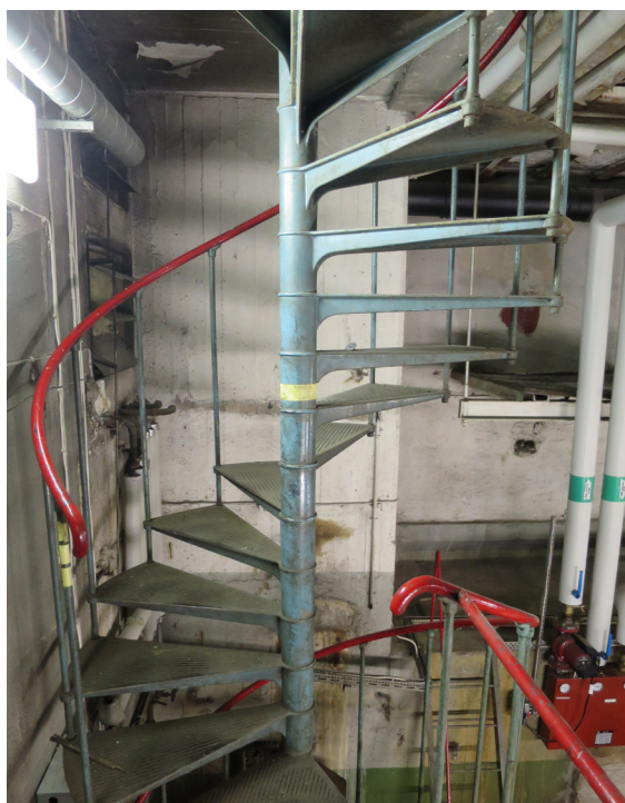
Spiraltrappan i pannrummet.
