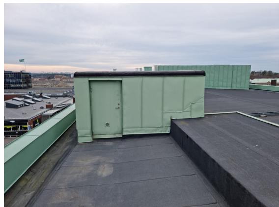
Taket sett från sydöstra delen, mot väster.
