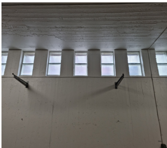
Ljusinsläpp på vardera långsidan i form av dubbla, travade betongglas i marknivå, strax under tak.
