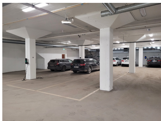
Källarvåningen. Platsgjutna betongpelare med svampformiga kapitäl.
