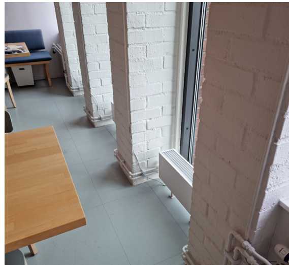
Pausrum mot söder på 2 tr, där fönsterbröstningarna har rivits ned till golvnivå i tre fönsternischer..
