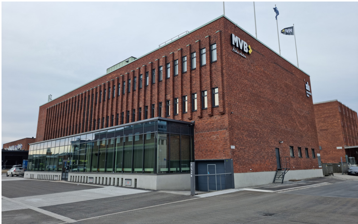
Mot nordväst från Charkmästargatan. Tidigare lastkaj med skärmtak har byggts om till glasad kontorsyta. Bilnedfarten till källare och garage syns centralt i bilden.
