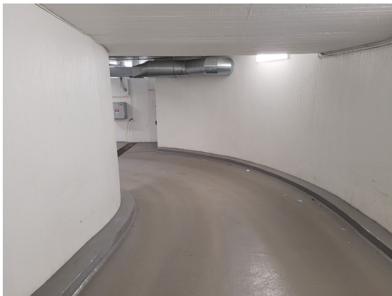
Nedfarten sedd innanför garageporten
