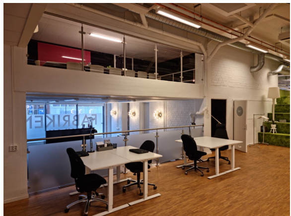
Östra delen av lastfickan sedd inifrån lokalen. Observera entresolvåningen ovanför, ursprungligen fungerande som lageryta.
