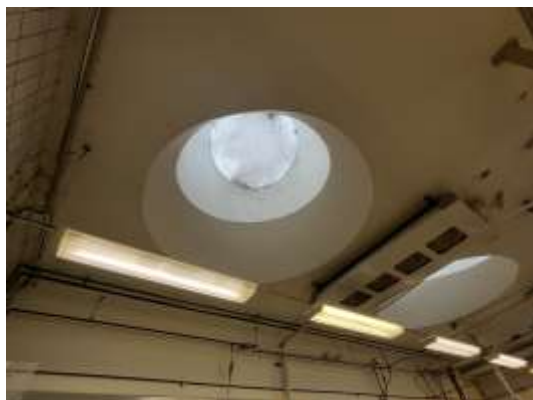
På den vänstra bilden syns de runda taklanterninerna i produktionslokalerna, bottenvåningen. På den högra bilden syns takfönstren i entréhallen.
