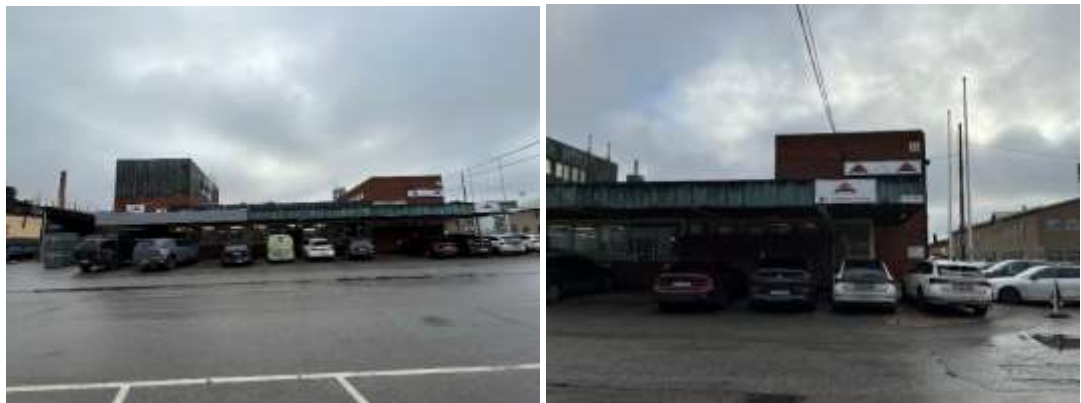
Utskjutande skärmtak mot Styckmästargatan, delar av Kopparplåten har tyvärr stulits.
