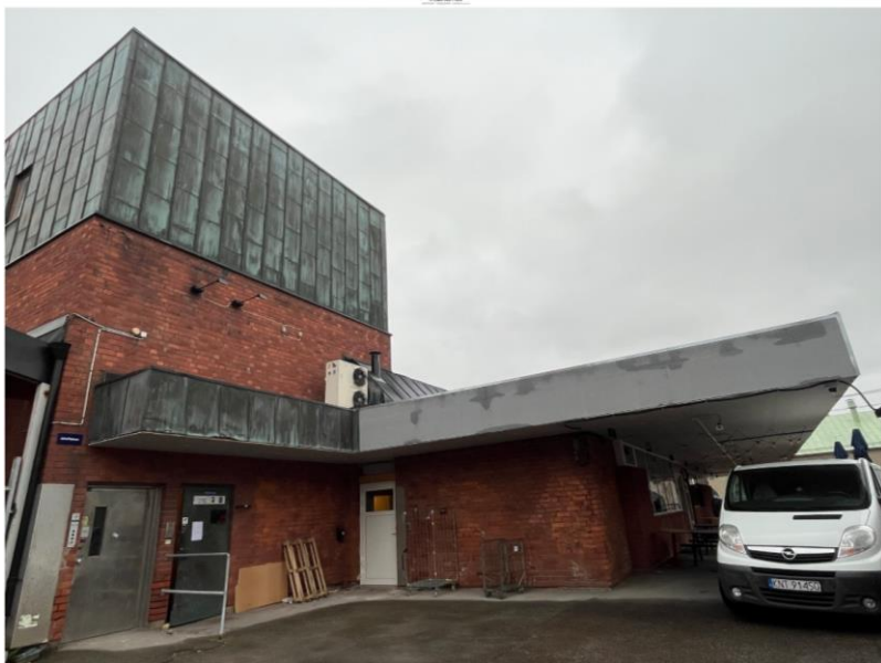
Skärmtaket sett från korsningen Slakthusgatan/Styckmästargatan.
