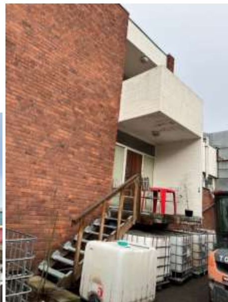
Fasader mot sydvost och sydväst. Balkong och vindfång i formgjuten betong.
