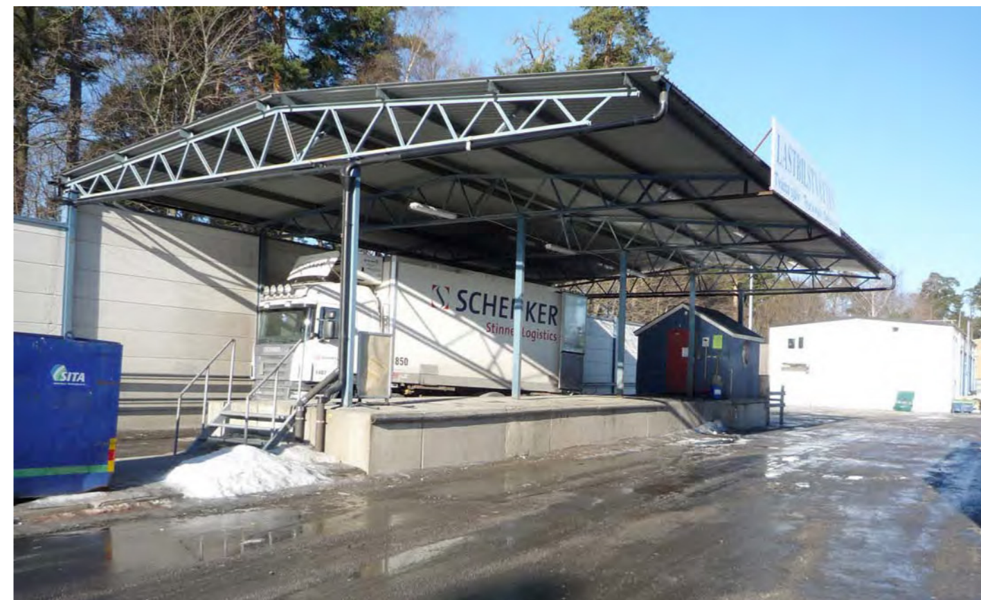
1 Tvättstationen med bakomliggande bullerplank.
