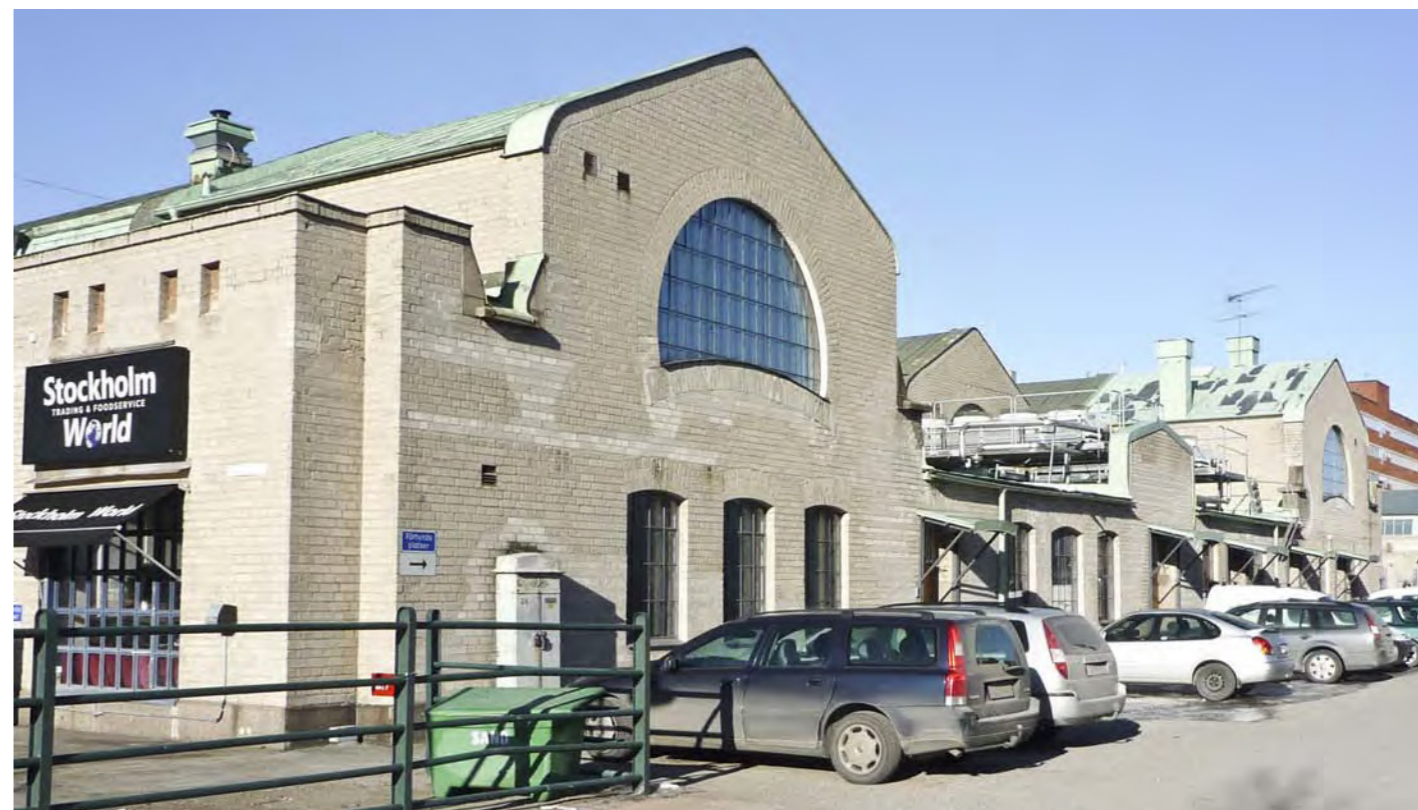
3 Kyl- och ventilationsutrustningen på taket förvanskar exteriören.
