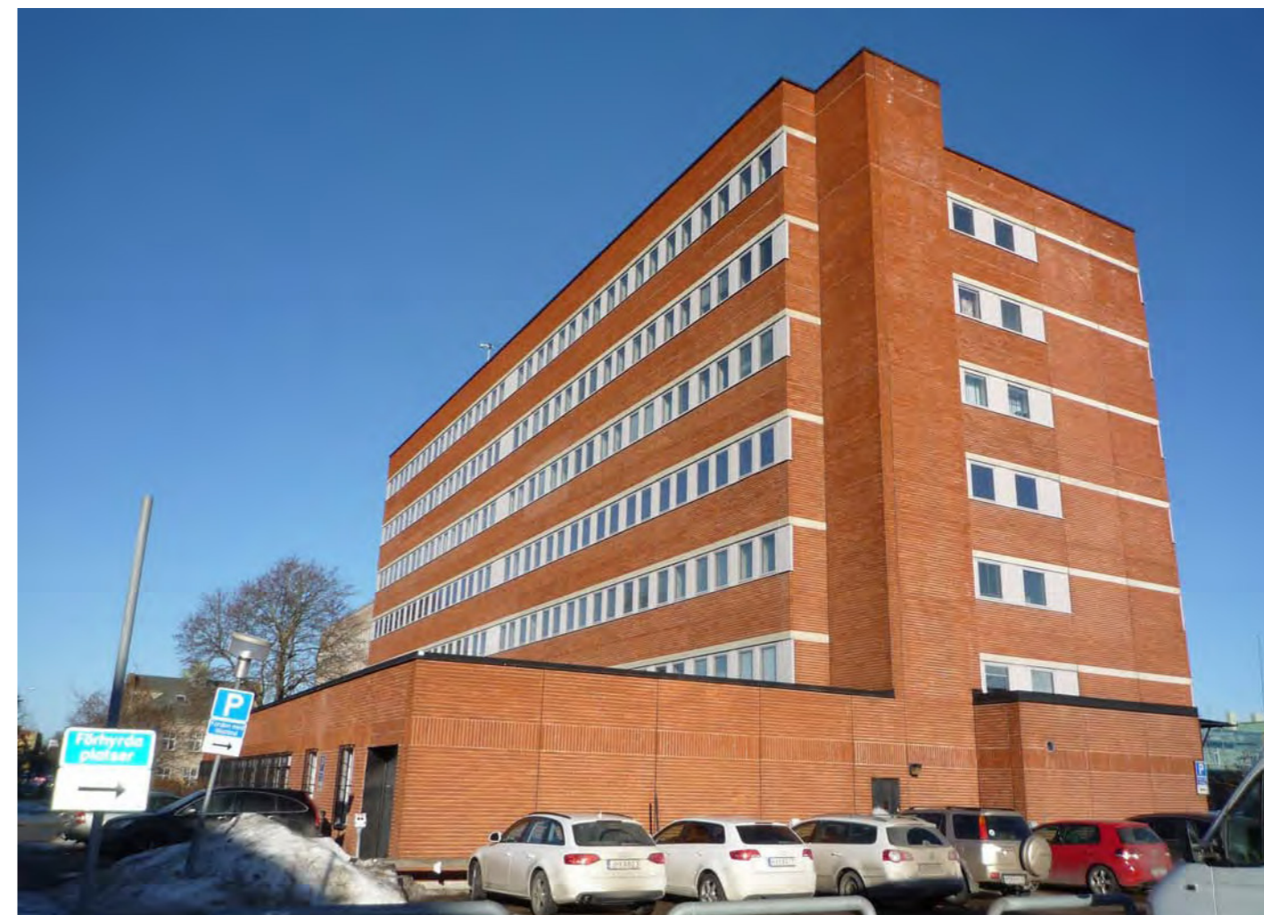
1 Fotografi från söder. Elementskarvarna syns i fasaden. 2 Bygglovritning. Källa: BNA.
