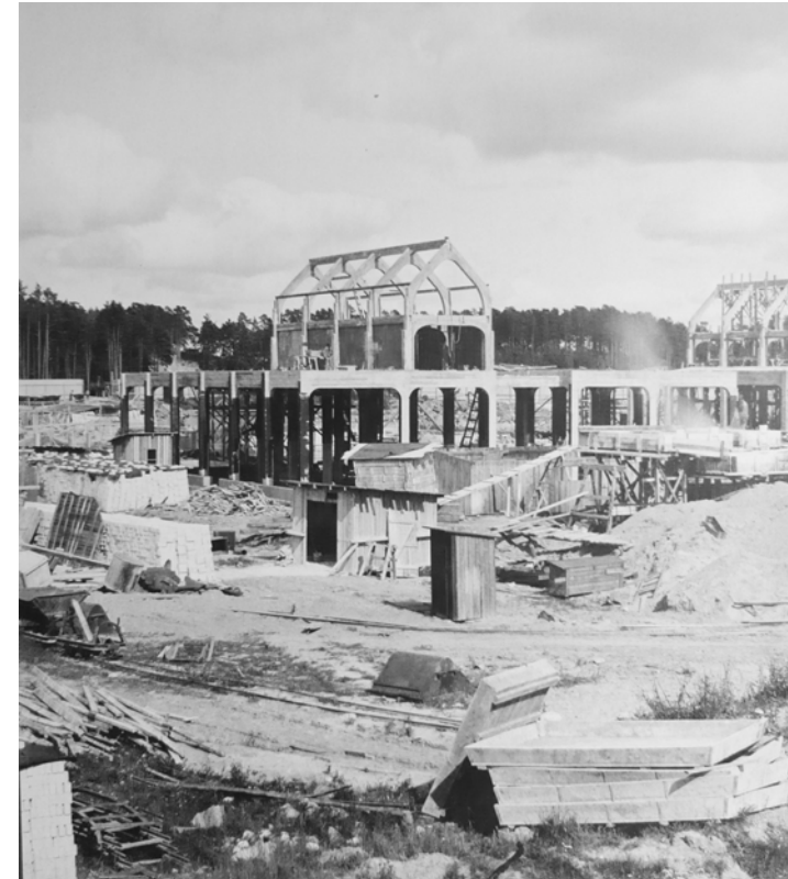
1 Längdsektion av ångpanne- och maskinhuset (13). Källa: SSA 2 Slakthall för småboskap (25) - stommen av armerad betong under uppförande ca. 1909. Källa: SSA 3 Interiör av förbindelsehallen (15 b).
