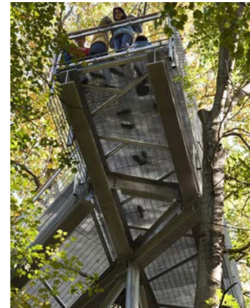
Utsiktsplattformar mot bergsskärningen, Källa: internet
