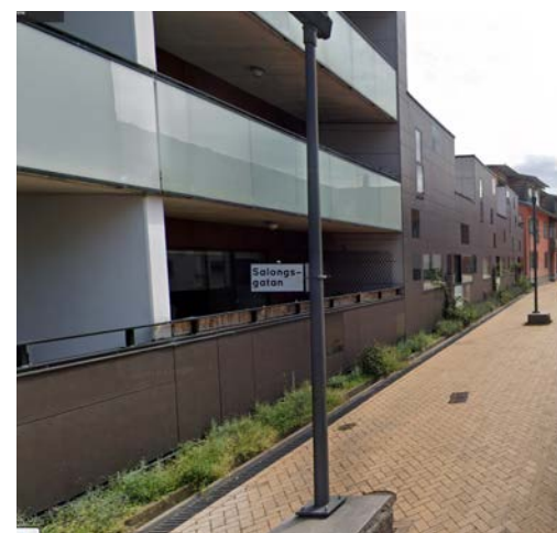
Exempel på en planterad fris (100% av fasadlängden är planterad) men som inte uppnår sitt syfte att bidra till ett grönare gaturum. (Google Maps)
