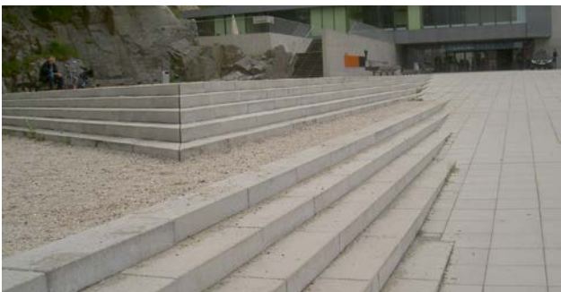
Trappor tar upp höjdskillnad mellan Arenavägen och torget
