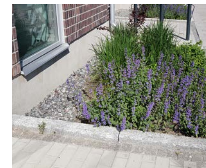
Planterad fris med utkastare, exempel från Sundbyberg
