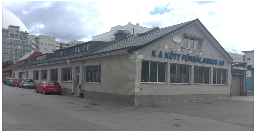
Sandhagen 14, Hus 16. Stadsbyggnadskontoret
