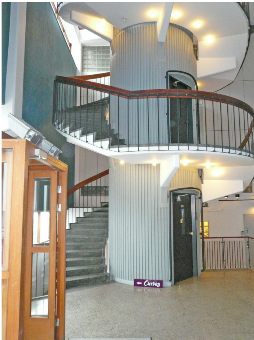
Över den slutna putsade väggytan till vänster börjar sedan högdelens öppna curtain wall-fasad. Rakt fram det runda hisschaktet med sin yta som trapetskorrugerad plåt. Ursprunglig armatur är monterad under trapplöpet med socklar som är infällda i betongen och nakna glödlampor.
