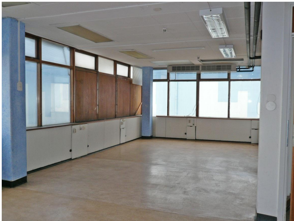
Rum 115 med de för chefsrummen så typiska teaskkivorna i fönstren. Ursprungligt undertak med infällda armaturer. Småsinuskorrugerad bröstning med öppningsbara luckor till installationer och vred. Ursprungliga fönsterpartier i curtain wall-fasaden och fönsterbänkar av teak.
