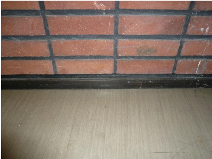
Fotlisterna på alla våningsplan utgörs av släta, svartmålade trälistor, som på denna bild, eller av svarta gummilister som på bilden nedan.
