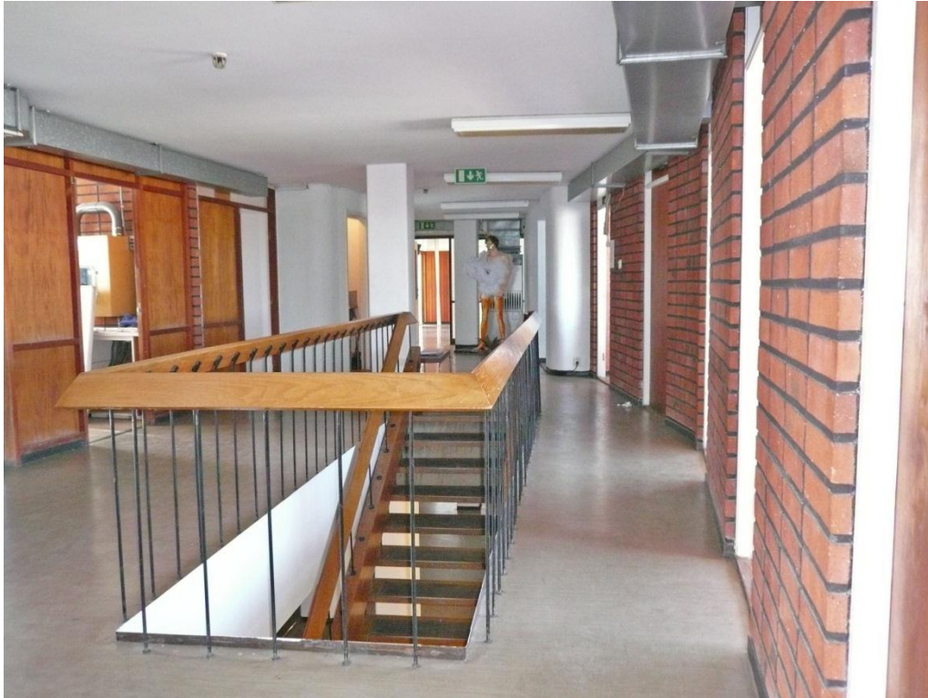
Hallen åt andra hållet. På trappans steg ligger samma typ av räfflad gummi matta som sitter på hissorgens innerväggar.
