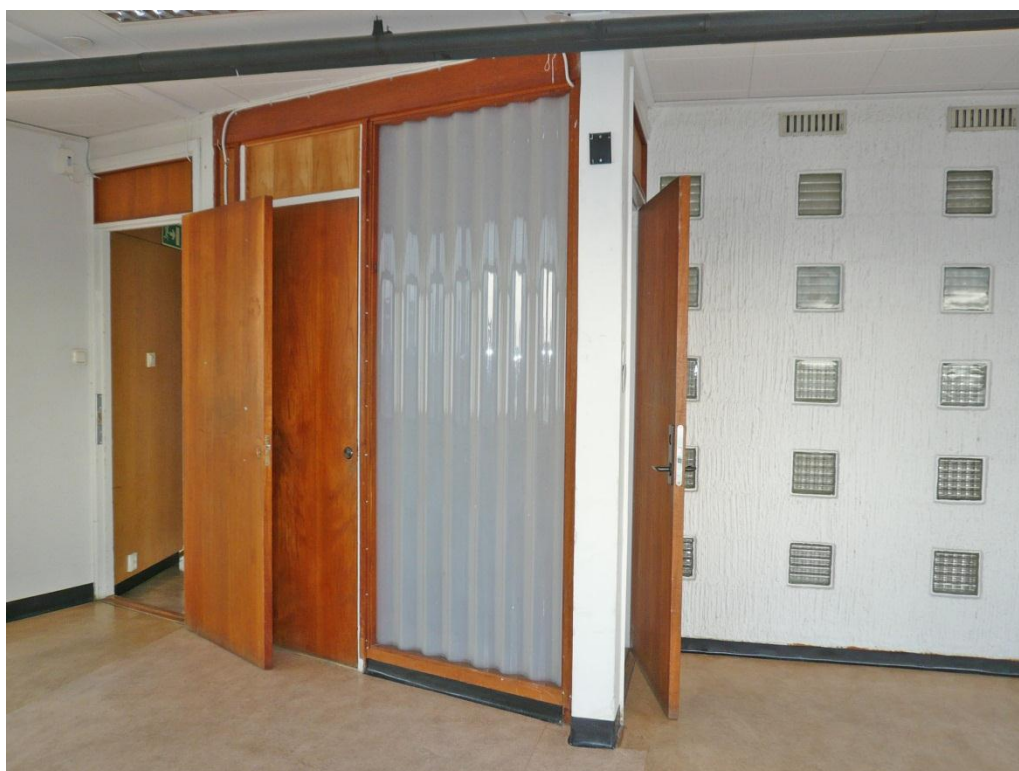
Rum 115 med sina intressanta väggmaterial av korrugerad plast och putsade lättbetongblock och betongglas. Typiska dörr- och väggpartier av teak.
