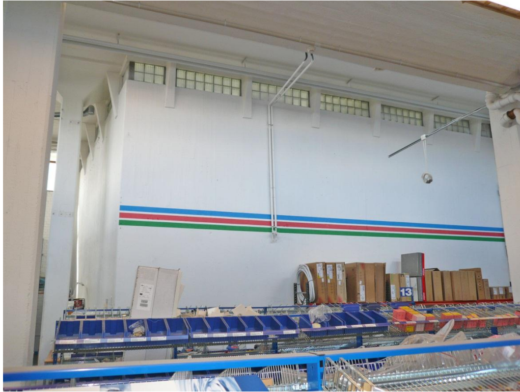
Huvudtrapphuset med entré från Hallvägen ligger innanför den vita kuben. Pelar- bjälklagkonstruktionen blir extra tydlig inne i Onninens lokaler.
