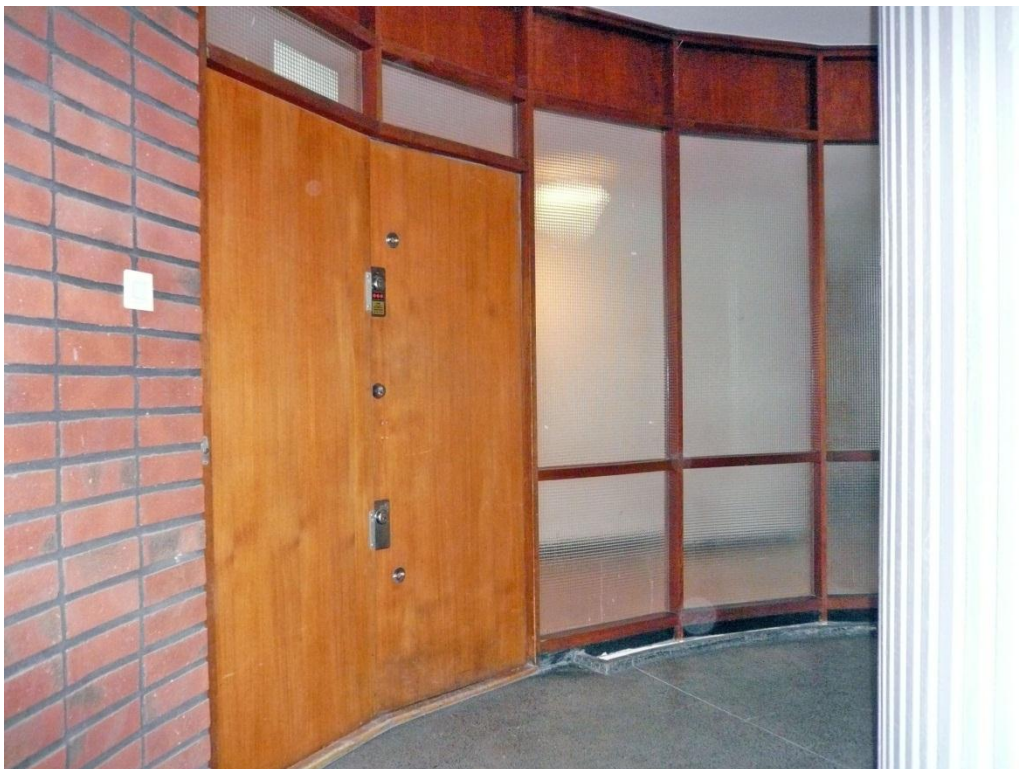
Den nedersta kontorsvåningen med entré som följer trapploppets form. Till vänster fasadtegel murat utan förband och med svarta fogar, ett tema som går igen inne i kontorsplanen.
