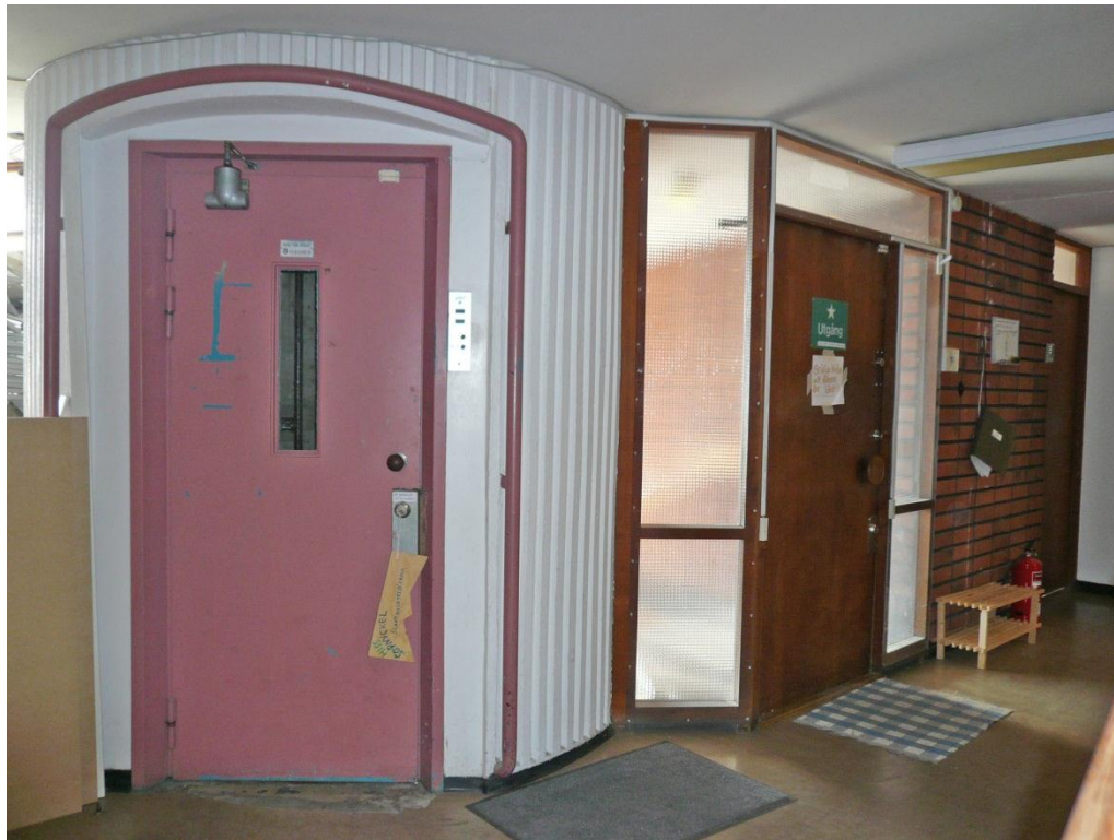
Entrén till våning 2 trappor med glasat teakparti. Här angör hissen direkt in på kontorsplanet. Runt hissens baksida löper en smal internttrappa upp till våning 3 trappor (för foto på trappa se våning 3 trappor).
