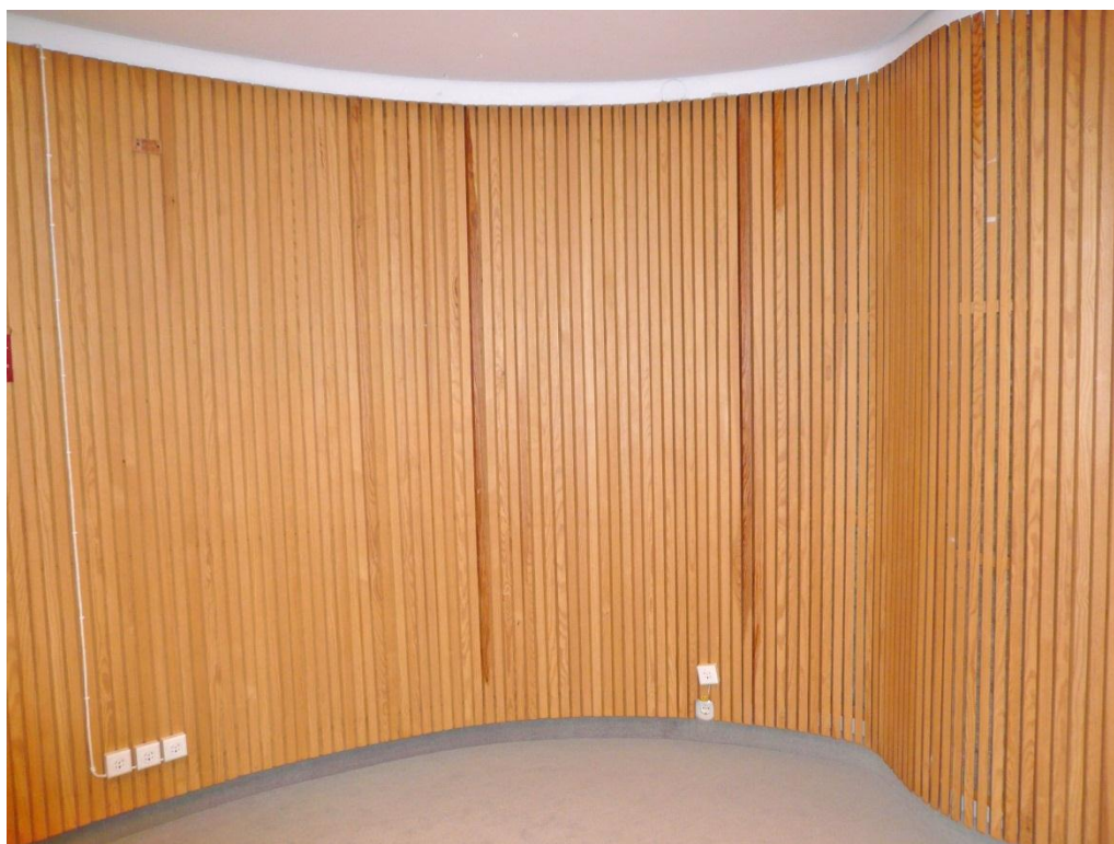
Rum 119 är helt klädd med en stående, smal furupanel.
