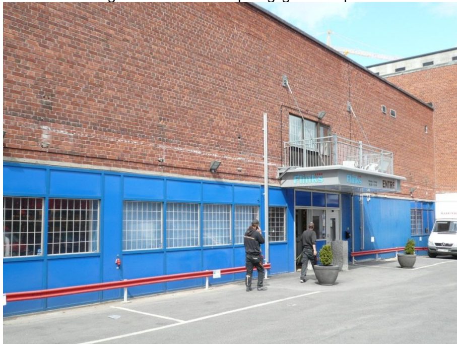
Souterrängvåningen. Till höger ett ursprungligt fönsterparti av teak och stående ursprunglig panel av teak samt ny panel av furu, som målats blå. Rakt fram en blåmålad aluminiumfasad med dörrar av aluminium.
