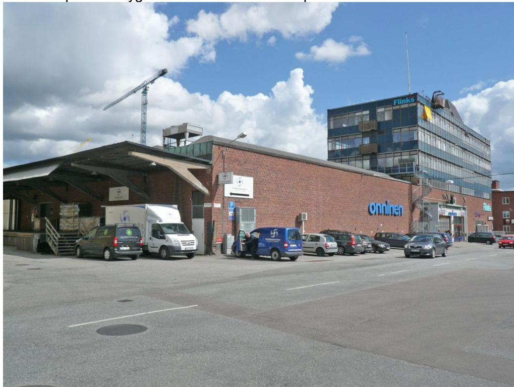
Fastigheten från nordväst. Lågdelen mjuka lanternintak anas över den slutna tegelfasaden.
