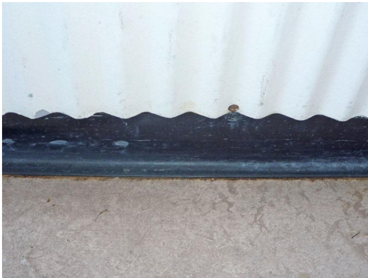
Svart, ursprunglig gummilist sitter i underkant av alla bröstningar.
