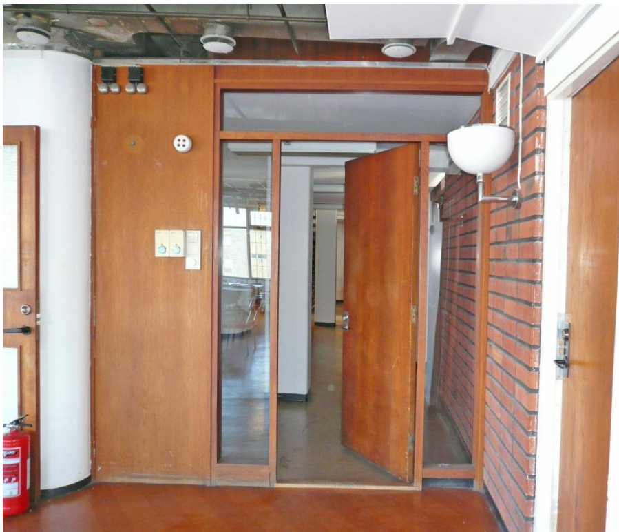
Rum 207, glasat teakparti mot den centrala hallen. Till vänster en teakdörr med frostat glas som leder till köket.
