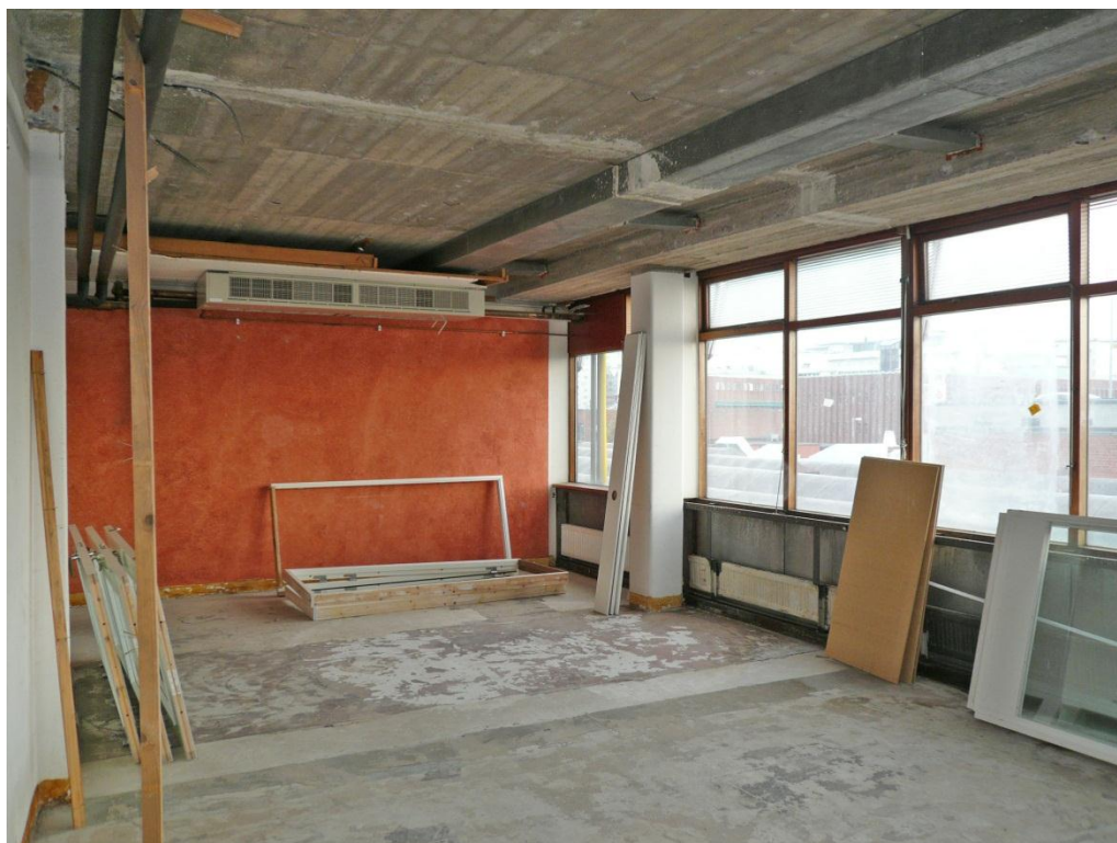
Rum 115 där renoveringsarbete påbörjats och ursprungliga material tagits bort. Till höger ser man hur radiatorerna är monterade i alla rum och den metallkonstruktion som bär fönsterbänkarna och fönsterbröstningarna. Under radiatorerna ska det finnas don för insprutning av varmluft. Rakt fram i bild kan man se hur undertaket varit monterat på träreglar.
