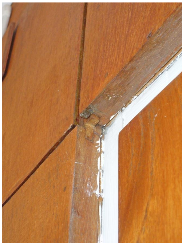
Detalj av teakpanelernas ihopfogning.
