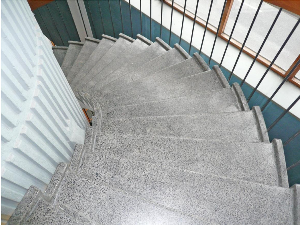
Trapploppet löper fritt från fasaden.
