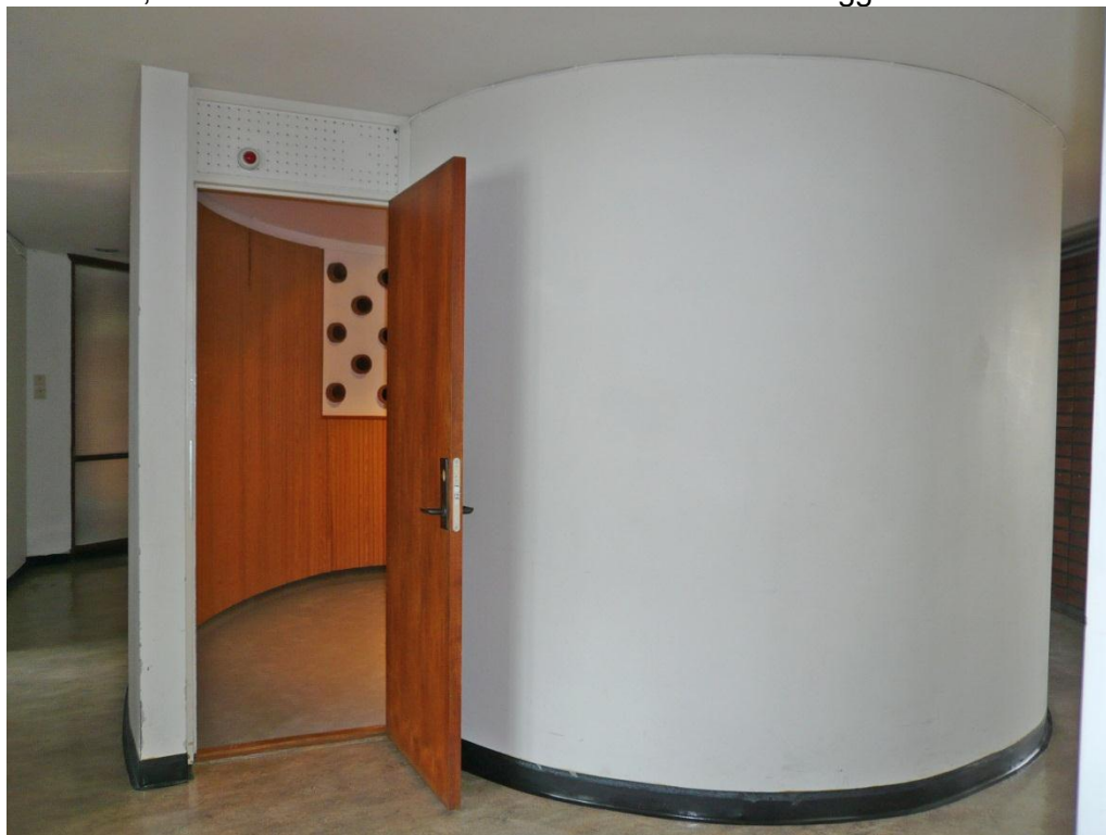
Konferensrummet, rum 119, från dess entrésida. Här ser man några av de 13 terrakottarören som leder till ventilationsschaktet.
