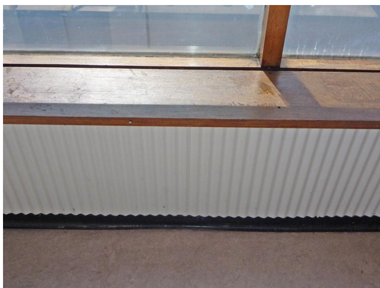
Närbild på ursprunglig fönsterbröstning av småsinuskorrugerad plåt.
