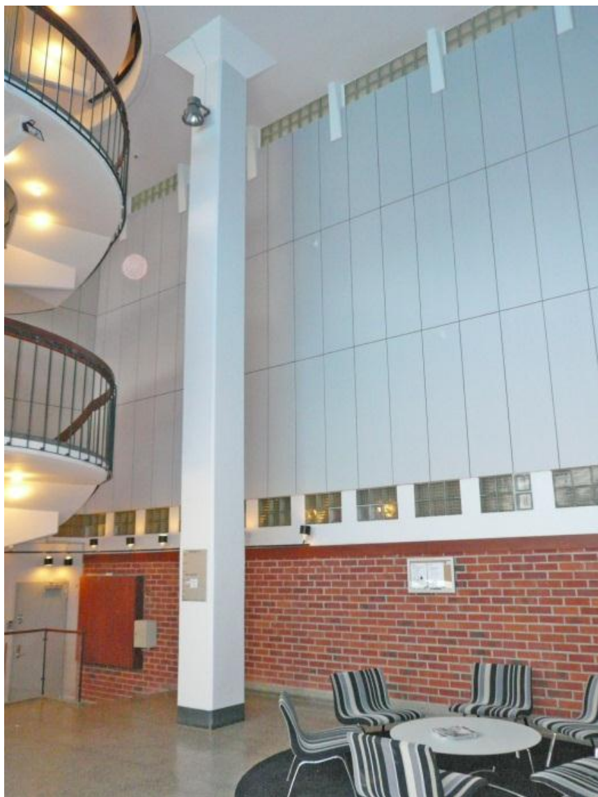
Pelarkonstruktionen är tydlig i trapphuset. Notera raderna av betongglas, en typ av glas Erskine ofta använde i industriarkitekturen.
