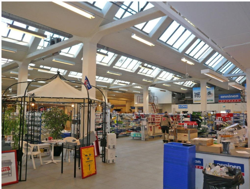
Onniners lokaler. Det böljande lanternintaket ger mycket ljus. Den bärande betongkonstruktionens takstolar har en dekorativ form.
