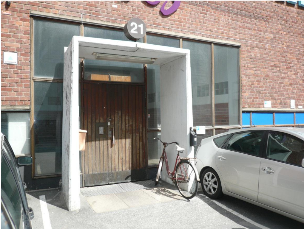
Den fristående portalen och klimatskyddet vid kontorsentrén.
