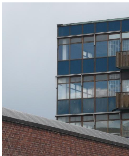
De bärande pelarna avtecknar sig innanför den lätta curtain wall-fasaden
