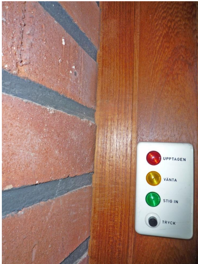
Exempel på detaljomsorgen. Dörrkarmen av teak är sågad så att den passar perfekt till teglets något indragna fogar.
