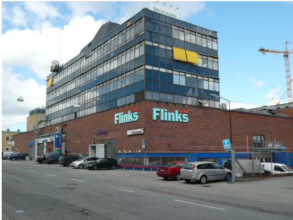
Från sydväst. Sveriges första fasadhiss för tvätt av glasfasad hänger längs taklinjen på långsidan.
