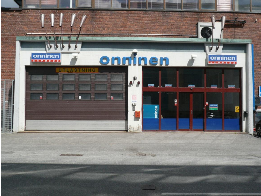
Den kraftfulla betongportalen med sina ursprungliga armerurer och takfot av kopparplåt.
