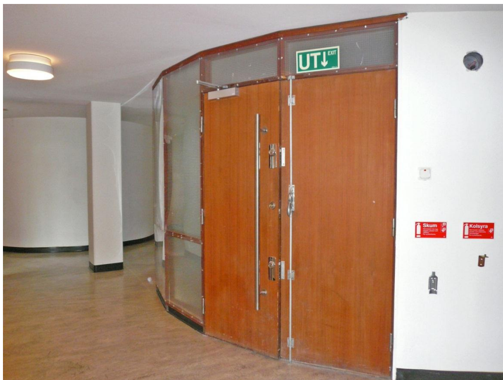
Entrépartiet av teak på plan 2 följer trapphusets runda form. I bakgrunden det ovala, helt slutna konferensrummet som ligger fritt i den längsgående hallen.
