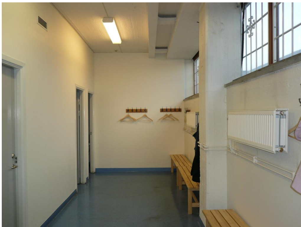
Omklädnings- och duschrum i gymmet på plan 1 ½. Här finns endast överljusfönster. Fönstren har ursprungliga teakpartier. Tak, pelare och väggar har ganska råa betongytor med spår av brädformar.
