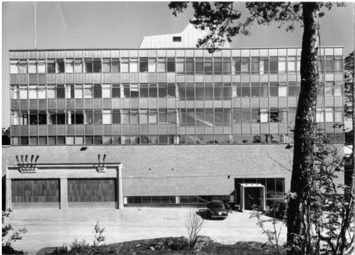
Charkuteristen 5 någon gång under 1950-talets andra hälft. Huvudfasad med lastintag och kontorsentré till höger. Foto från Arkitekturmuseet, Fotograf Sune Sundahl.
