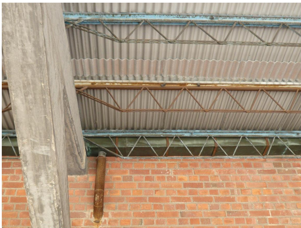
Närbild på fackverkskonstruktionen som bär skärmtaket.
