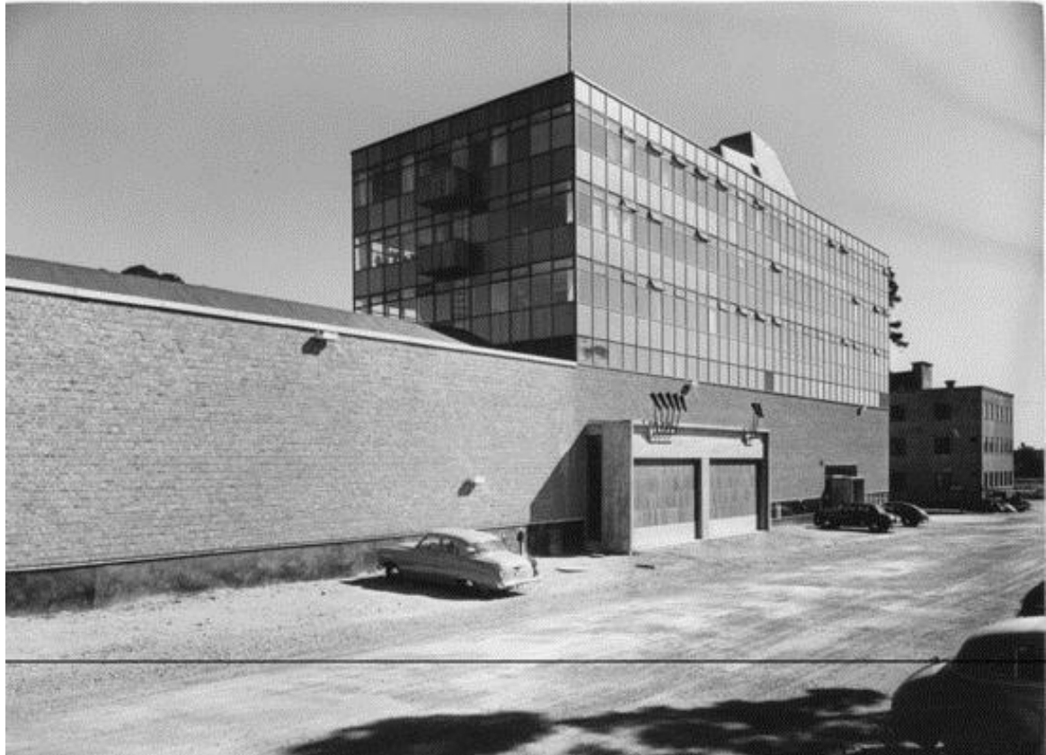
Fastigheten från nordost, 1950-talets andra hälft. Foto från Arkitekturmuseet, Fotograf Sune Sundahl.
