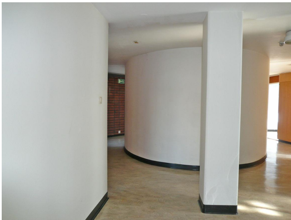
Det ovala helt slutna konferensrummet. I bakgrunden till vänster en vägg med rött beklädnadstegel med svarta fogar och till höger en vägg klädd med furupanel.
