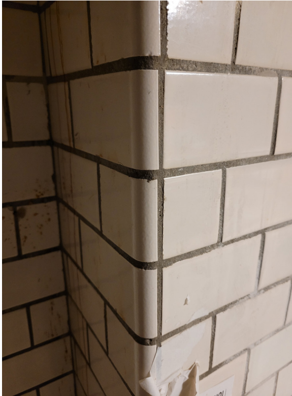
Kakelbeklädning på vägg i källare. Format och särskilda hörnplattor vittnar om att kaklet är från 1930-50-tal. Del 1.
