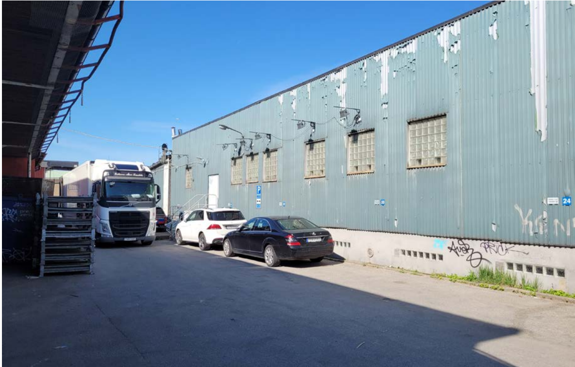
1930-talsdelens långsida mot sydost. Byggnaden hade sannolikt vanliga träfönster före 1960-talsombyggnaden då glasblocken sattes in. Under plåten sitter enligt muntlig uppgift eternitskivor.
