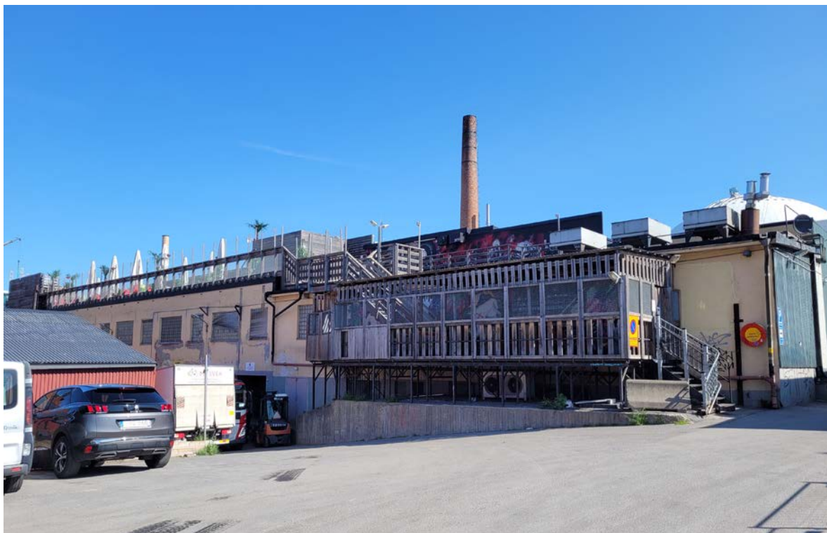
Foto som visar byggnadens södra hörn med utrymningsdel och förbindelse mellan invändiga nattklubbslokaler och uteservering på takterrasser. Den öppna tillbyggnaden döljer stora delar av 1942 års tillbyggnad av Del 1.
