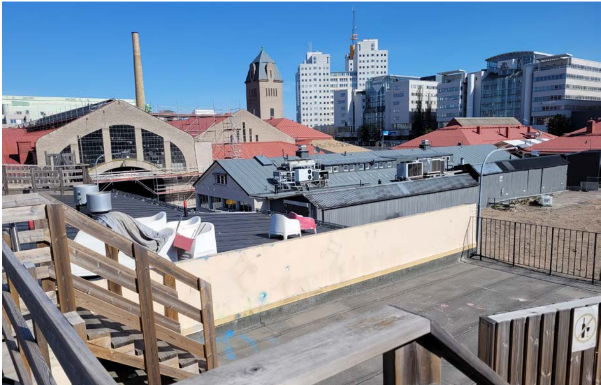
Längs nordöstra sidan av Del 2 är vissa delar av taket tillgängliga.
