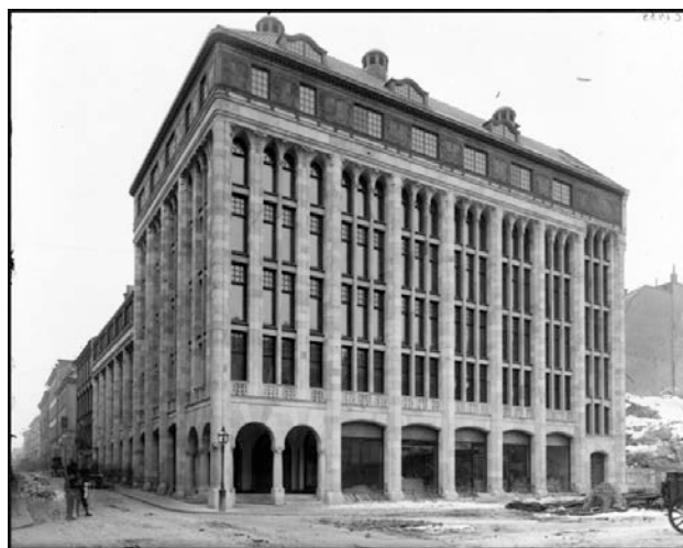
Myrstedt & Sterns byggnad, från 1910, i hörnet Kungsgatan-Norrlandsgatan i Stockholm är en av Kreuger & Toll AB:s mest kända byggnader, med en konstruktion som var nydanande för byggnadstekniken i Sverige. Källa: Stockholmskällan.
