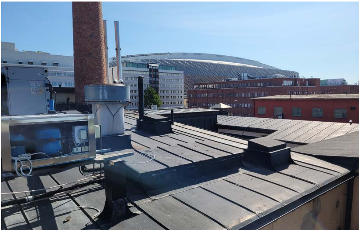
Taklandskapet är delvis svåröverskådligt. De södra delarna har inte kunnat belastas med uteserveringsytor och uppvisar bandtäckt plåt från 1900-talets senare del. I förgrunden Del 2, där bakom Del 1.
