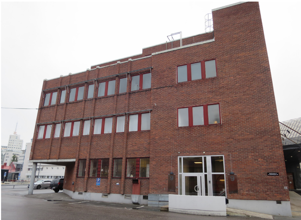
Fasad mot Slakthusgatan med huvudentré. Lägg märke till det sneda fasadindraget med betongpelare.
