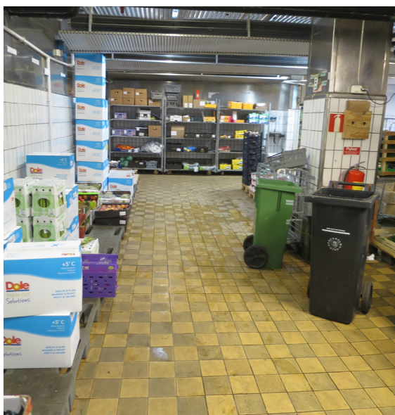
Bottenvåningen. Ytskikten med kakel och klinker finns kvar från ursprunglig köttantering.
