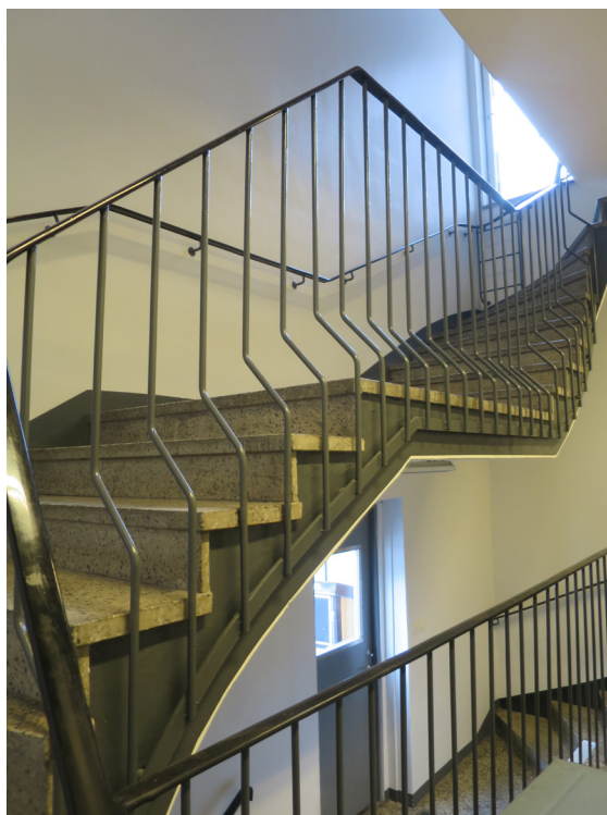
Trapphus beläget mot fasaden i sydost.
