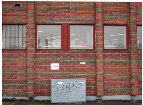
Fönster i bottenvåningen.
