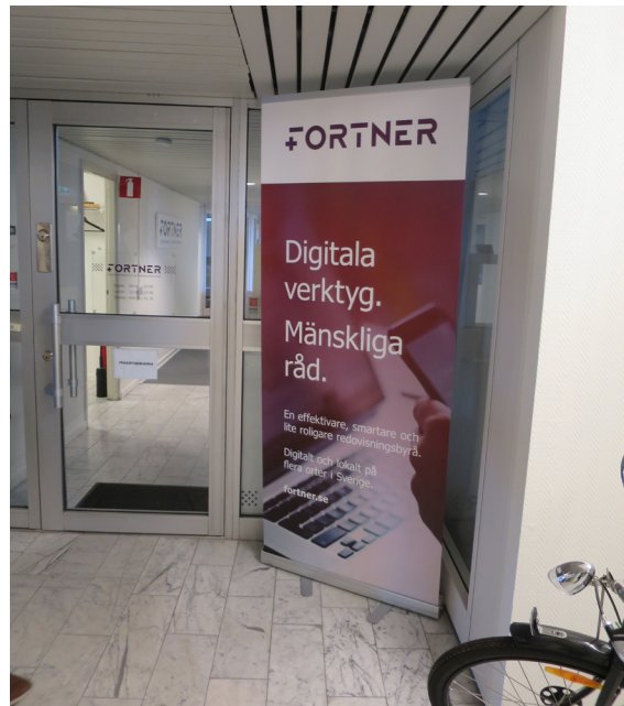
Utbytt entrédörr 3 tr. På detta plan finns ett förrum mellan trapphus och kontor. Golv är troligen inte original.
