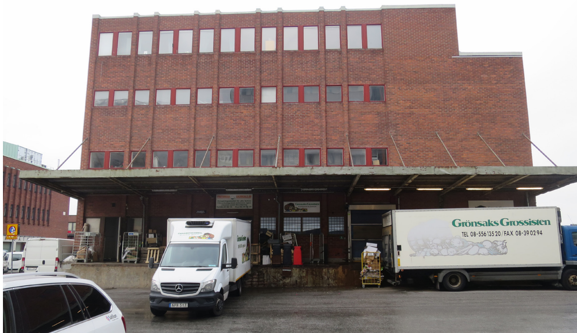
Fasad från Rökerigatan. Lastbrygga med skärmtak utmed hela fasaden.
