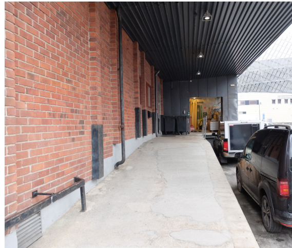
Lastbrygga med tillbyggnad. Plåtskydd på lisenerna.
