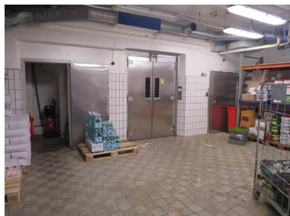
Källarvåningen. Dörr till trapphus, hissdörrar och dörr till frysrum. Ursprungligen utrymmen för köttantering och förädling.
