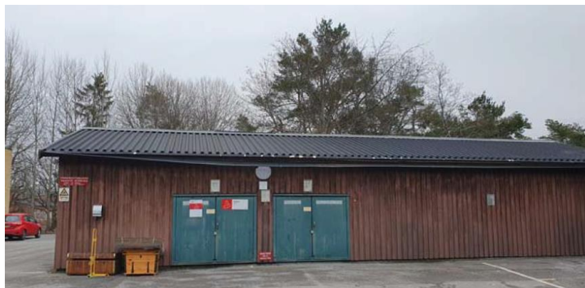
Förrådsbyggnaden från 1982 (bild: Wilund arkitekter och antikvarier).
