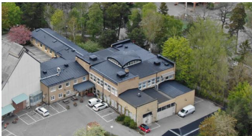
Kontorsbyggnaden med senare tillbyggnader på södra och norra fasaden.
