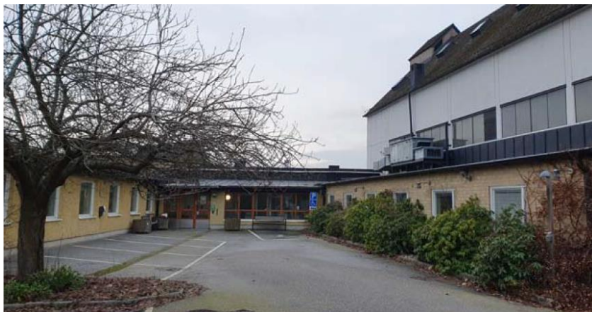
Det stora glaspartiet mot nordöst är nästan helt igenbyggt efter att en kontorsdel i en våning byggts till (bild: Wilund arkitekter och antikvarier).
