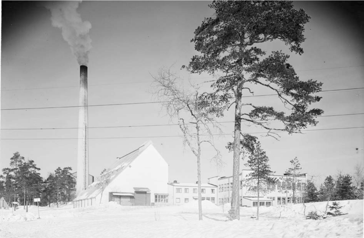
Panncentralen fotograferad vintern 1952 av Sune Sundahl. Förmodligen är anläggningen helt nyuppförd vid fototillfället. Notera det öppna läget vid parkstråket. Detta är numer bebyggt. Notera också avsaknaden av stängsel. Ur ArkDes samlingar. ARKM.1988-111-15954
