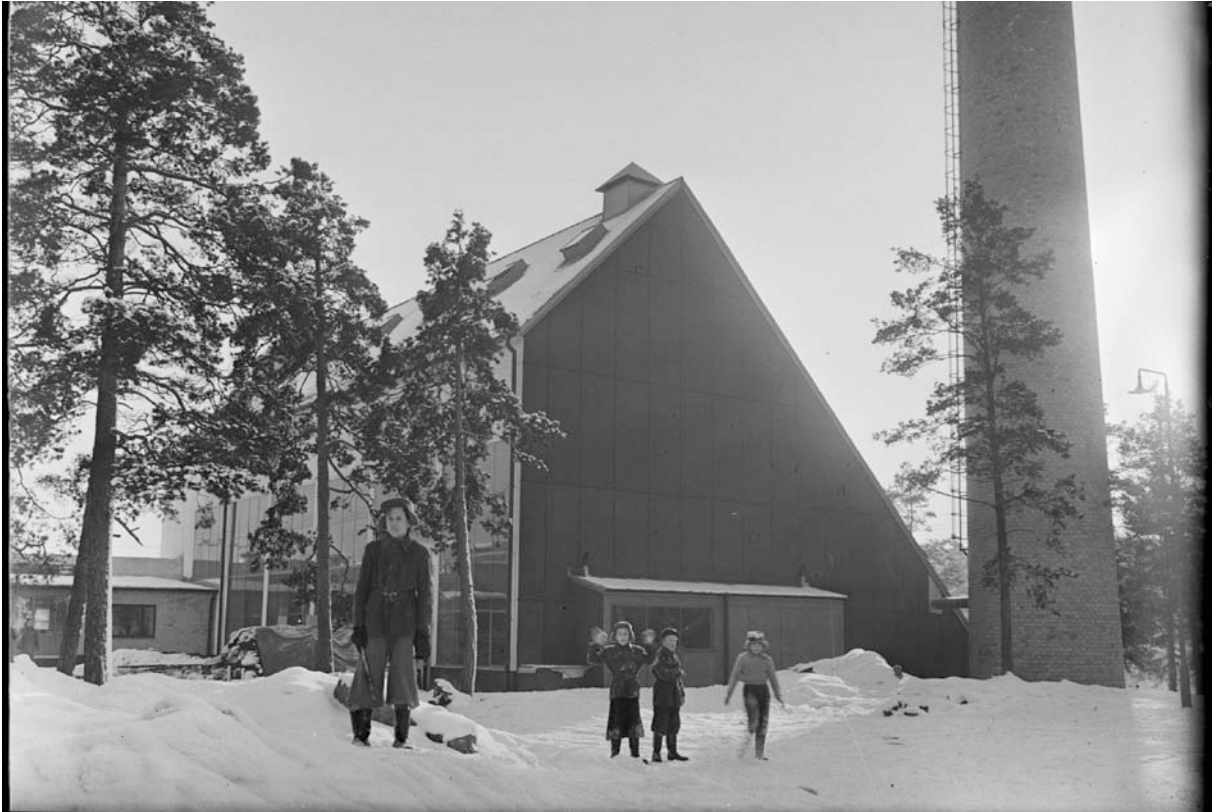
Panncentralen fotograferad vintern 1952 av Sune Sundahl. Vy från Kristallvägen i norr. Notera den nästan helt glasade norrfasaden. Ur ArkDes samlingar. ARKM.1988-111-10228
