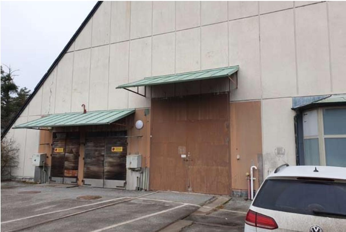
Lastportarna på södra gaveln. Portar och skärmtak förmodas vara ursprungliga, dock noteras att portarna på bygglövrningen samtliga hade samma höjd. Notera den sekundärt bytta entréutbyggnaden som skymtar till höger.
