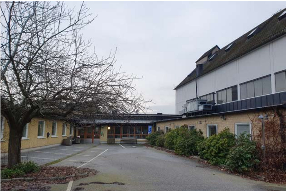
Det genom successiva tillbyggnader tillkomna gårdsrummet mot nött. Samtliga synliga byggnadsdelar utom den uppskjutande delen av själva panncentralen är senare tillbyggnader.
