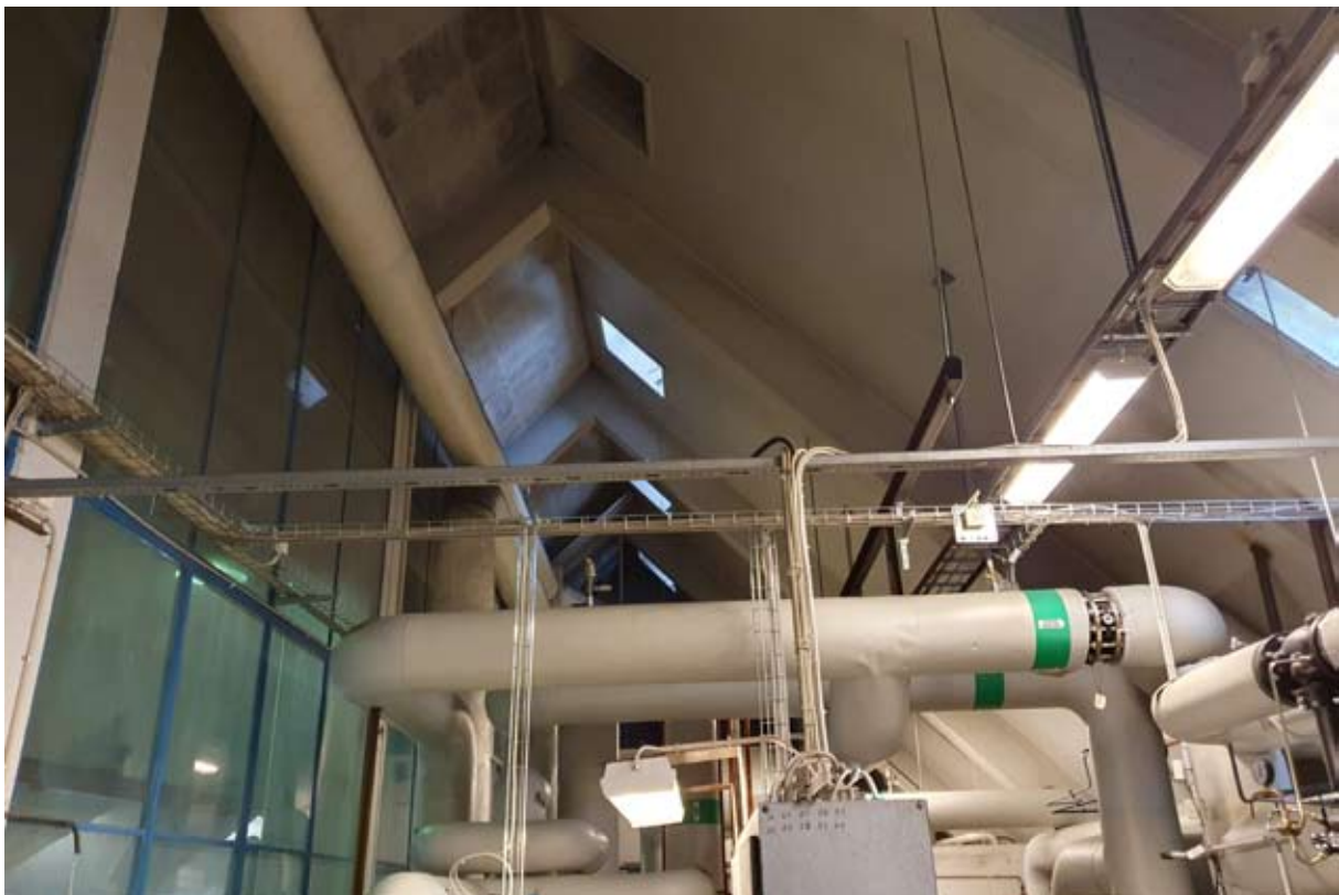
Interiör från den södra delen av pannrummet, med takfönster och dubbelhöga glaspartier.
