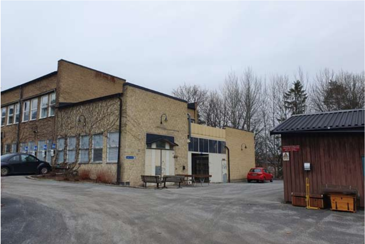
Tvättbyggnaden från söder. Utbyggnaderna mot söder är uppförda under en period från 1960-talet fram till 2000-talet, men följer den ursprungliga byggnadens fasadgestaltning. Närmast i bild tillbyggnaden från 1966.
