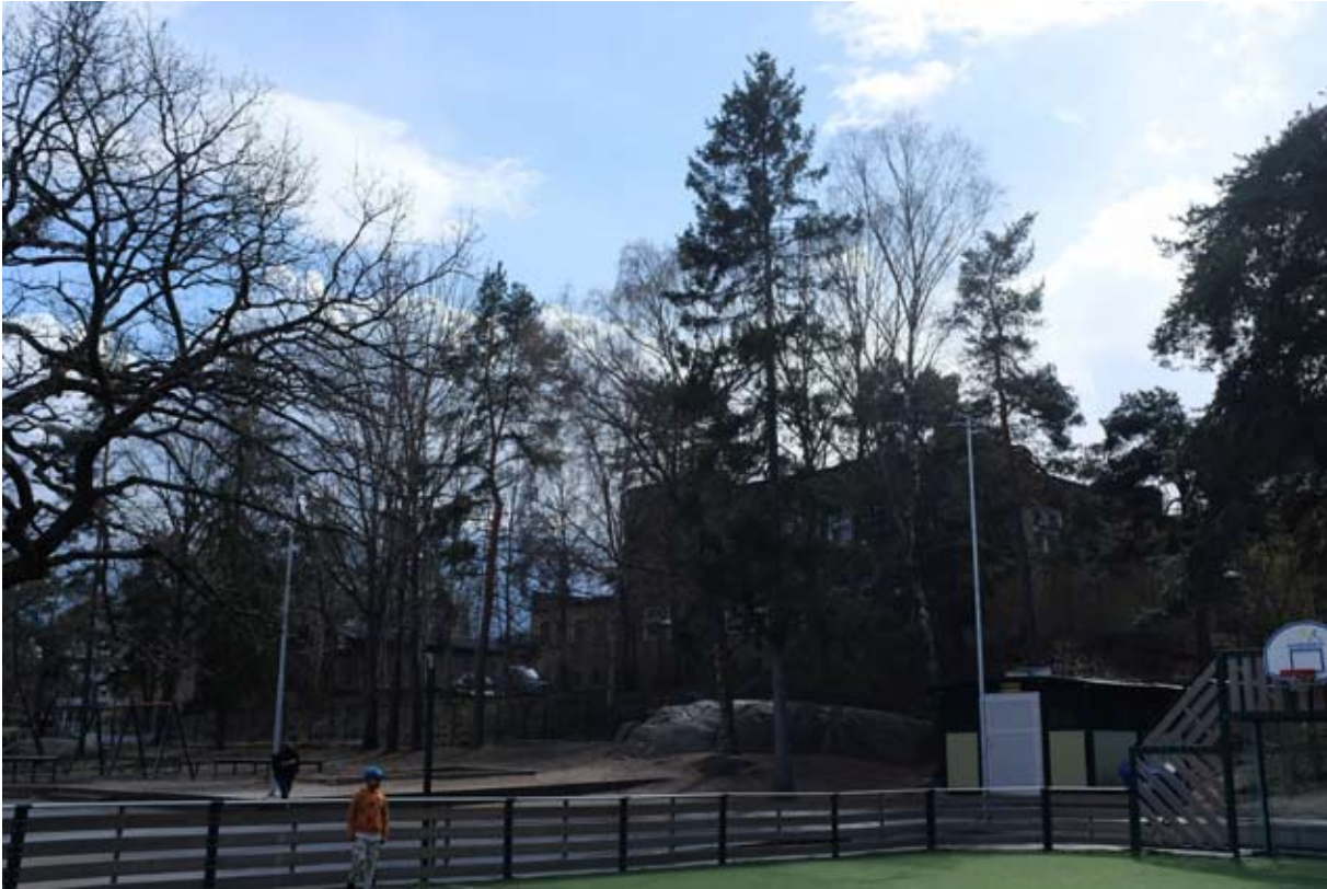
Anläggningen från Solbergaskolans gård. Ursprungligen låg det en byggnad på skolans område i bildens mitt. Panncentralens tvättbyggnad skymtar på höjden bland träden.
