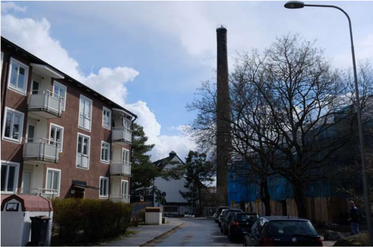
Panncentralen i fonden av Kristallvägen från norr. Motivet idag försvagat av instängslingen.
