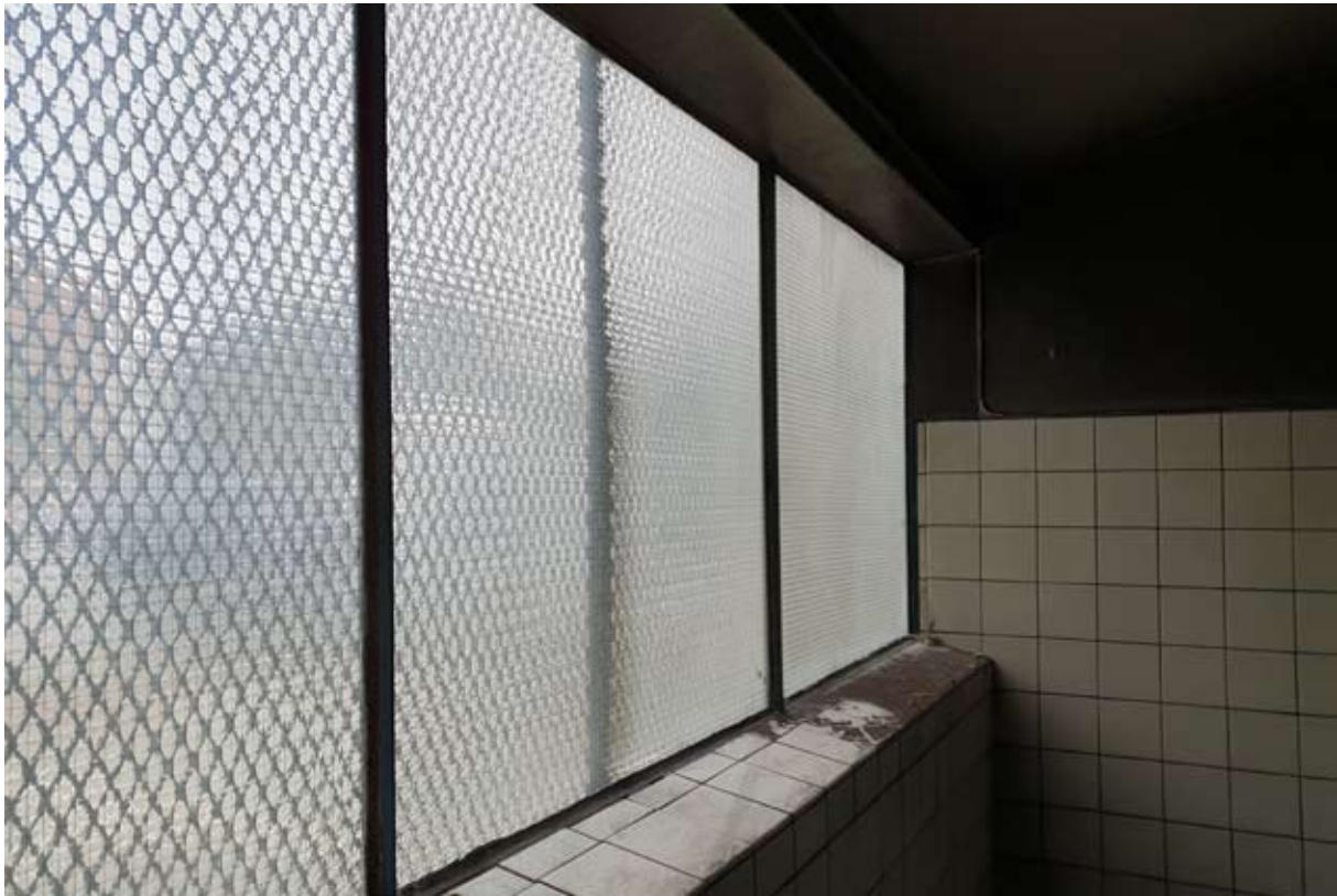
Detalj av trådglasfönster samt kaklad fönsterbänk. Exteriört sträckmetallgaller sannolikt sekundärt.
