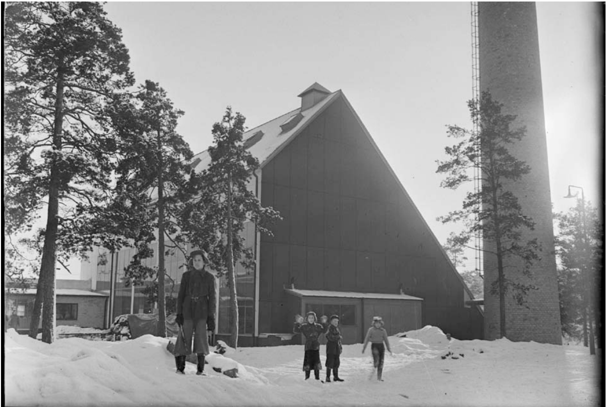
Panncentralen fotograferad vintern 1952 av Sune Sundahl. Vy från Kristallvägen i norr. Notera den nästan helt glasade norrfasaden. Ur ArkDes samlingar. ARKM.1988-111-10228
