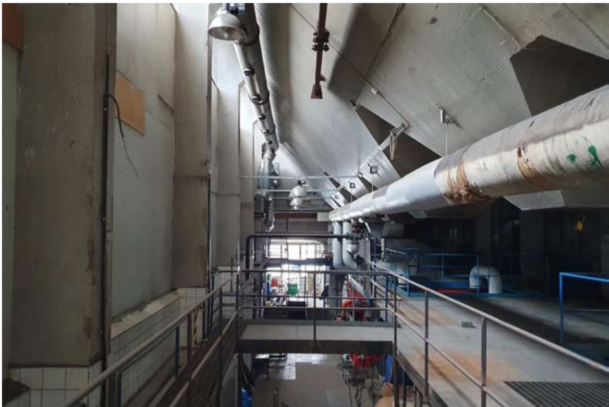
Interiör från pannrummet, med kolsilorna i platsgjutet betong synliga till höger i bild. Den vänstra väggytan mellan pelarna var ursprungligen glasad från innertaket ned till kakelbröstningen.
