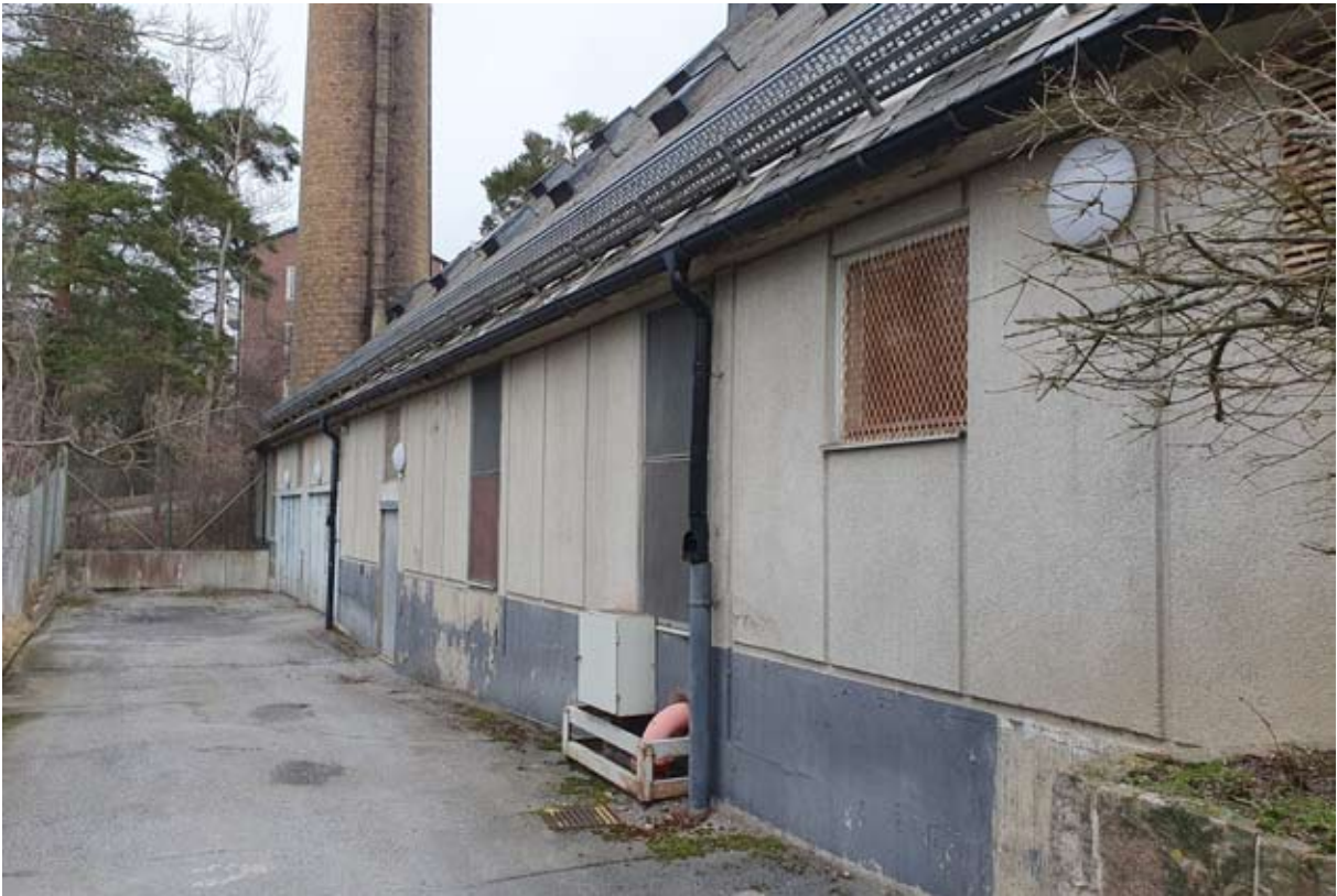
Fasaden mot Folkparksvägen. Den ursprungliga regelbundna indelningen är svår att avläsa idag efter att tre nya portar tillkommit.
