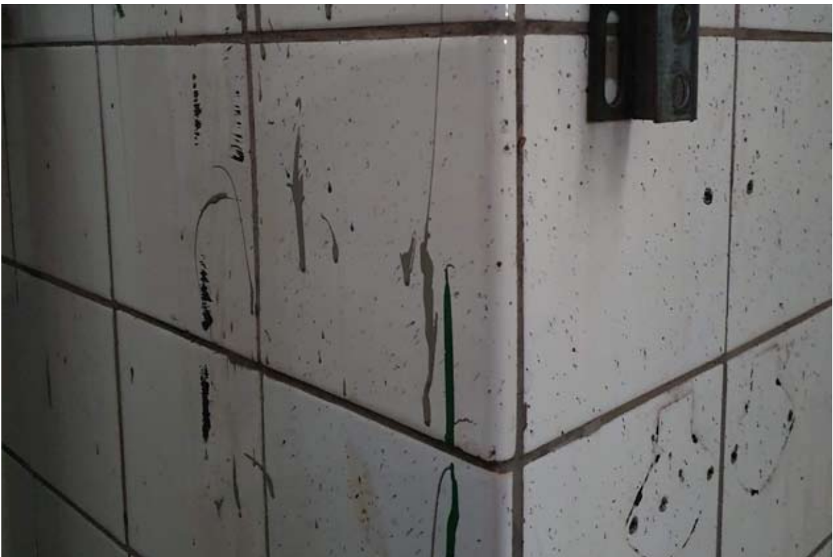
Detalj av väggkachel med rundad glaserad kant i typiskt funktionalistiskt utförande. Med färgstänk från 70 år av verksamhet.
