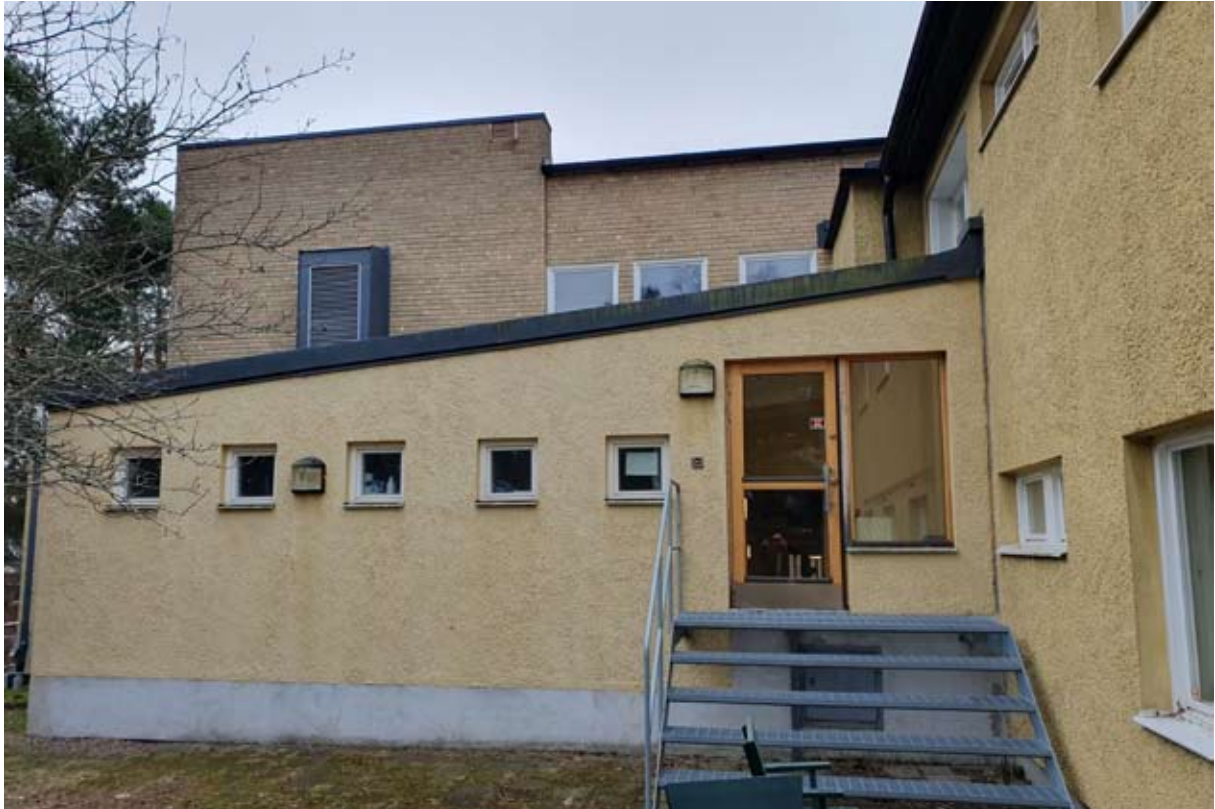
Tvättbyggnaden från norr, med tillbyggnader från 1988 och 1991.
