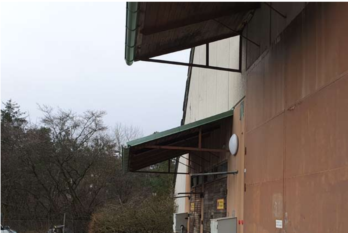
Detalj av skärmtaken. Bärning i stål, underlag av råspont, täckta med plåt.
