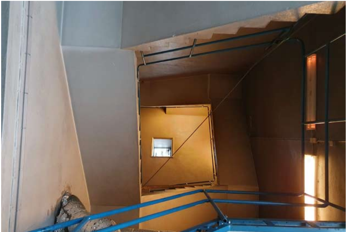
Trapphus i byggnadens sydöstra del.
