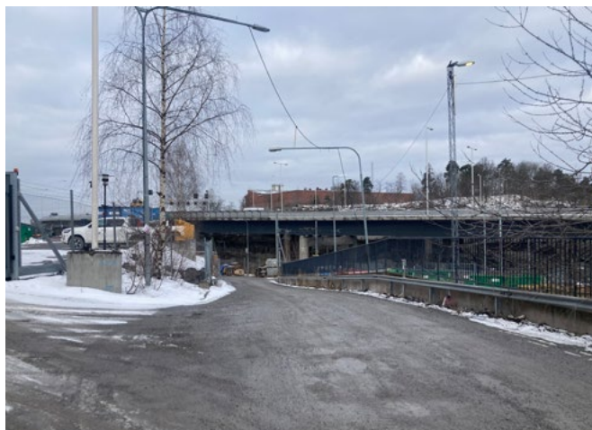
Utredningsområdets mitt. En väg leder ner till tidigare järnvägsspår.
