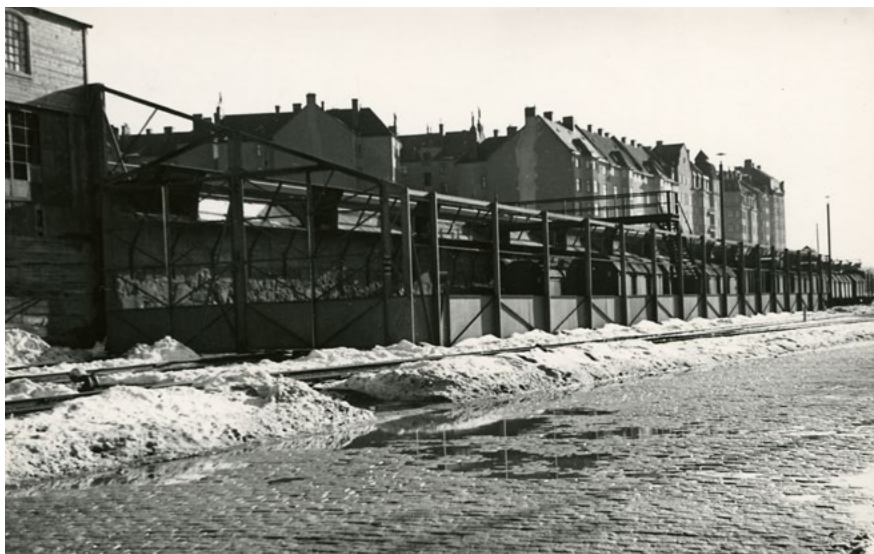
Soplastningsstationen, okänt årtal. Källa: SSM.
