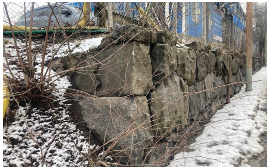
Närbild på muren utmed Norra stationsgatan.
