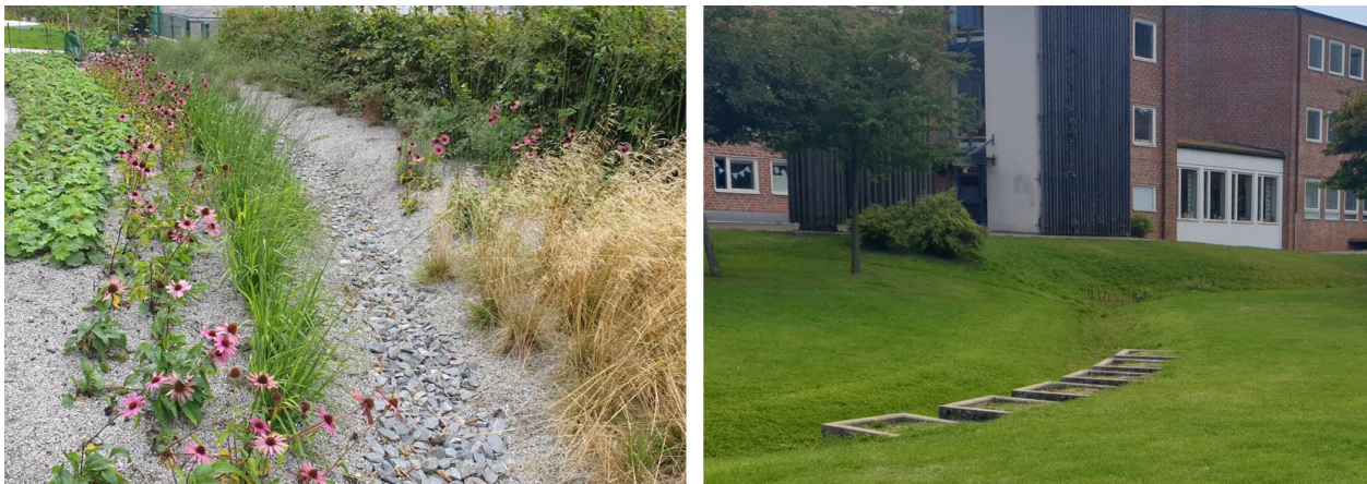
Figur 20 Svackdike med gruskrossfyllnad, Hammarby Sjöstad (t.v.) och stor överdämningsyta med svackdike, Augustenborg (t.h.)
