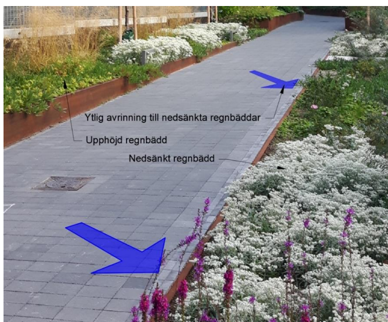
Figur 17 Illustration över en kombination av upphöjda respektive nedsänkta regnbäddar med ytlig avrinning från hårdgjord mark till nedsänkta grönytor
