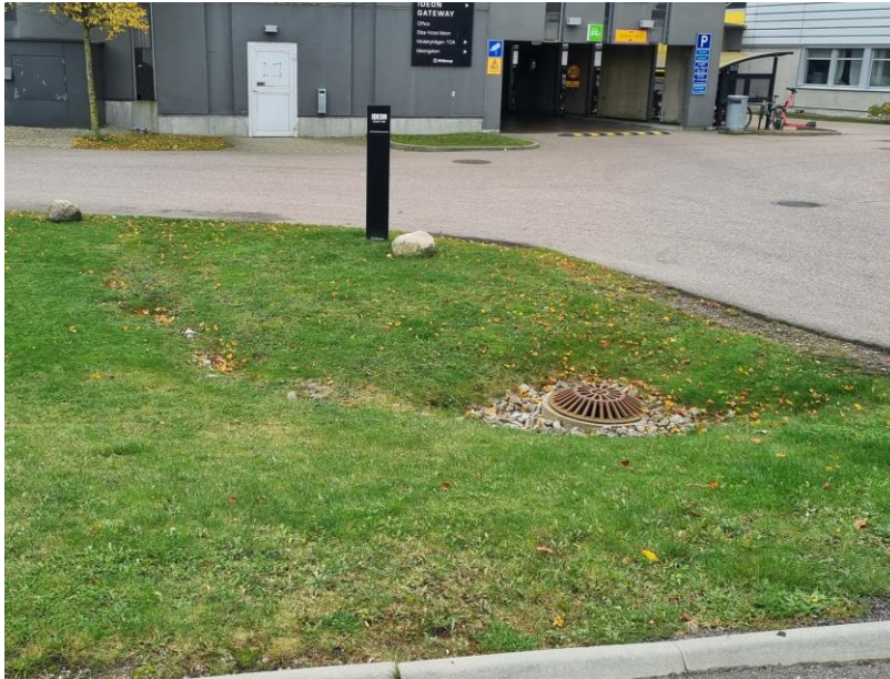
Figur 18 Svackdike med stenkrossdike och bräddavlopp
