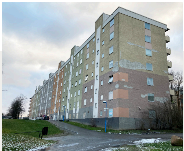
Byggnadernas gestaltning med rena och raka linjer, repetitivt uttryck och platta tak. Bild: White arkitekter
