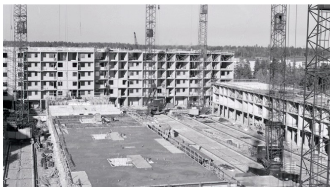
Exempel på kranbanor, bild från uppförandet av Hallonbergen 1969. Bild: Gösta Nordins Arkiv
