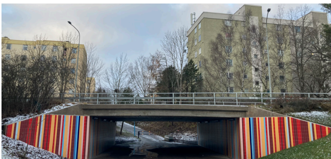
7 – Vy västerut vid gångtunnel mot bensinstation
