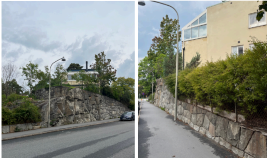
Foto över naturstensmuren som gränsar mot Tranebergsvägen. Bild Sawa antikvarier.
