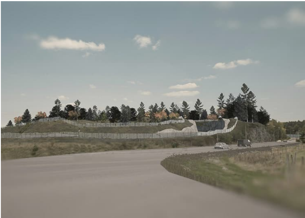
Figur 8. Bilden visar en vy över öglan från östra sidan av förbifart Stockholm. Närmast i bilden syns Akallalänken och en vegetationsyta som blir kvar mellan Akallalänken och avfarten. Stängsel på båda sidor av vägen är också synliga i bilden. I vyn syns bergskärningarna på vardera sida om avfarten och hur vegetationsytan förväntas se ut när vegetationen är ungskog.
