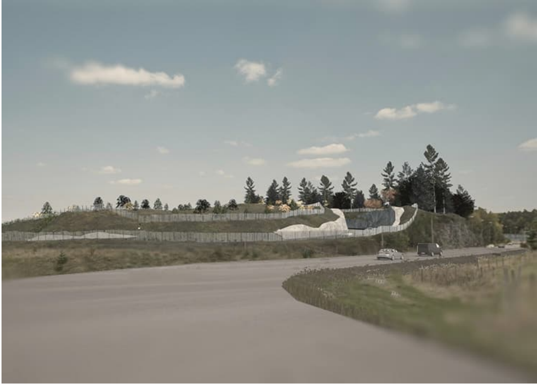
Figur 7. Bilden visar en vy över öglan från östra sidan av förbifart Stockholm, se placering i figur 1. Närmast i bilden syns Akallalänken och en vegetationsyta som blir kvar mellan Akallalänken och avfarten. Stängsel på båda sidor av vägen är också synliga i bilden. I vyn syns bergskärningarna på vardera sida om avfarten och hur vegetationsytan förväntas se ut under etableringstiden.
