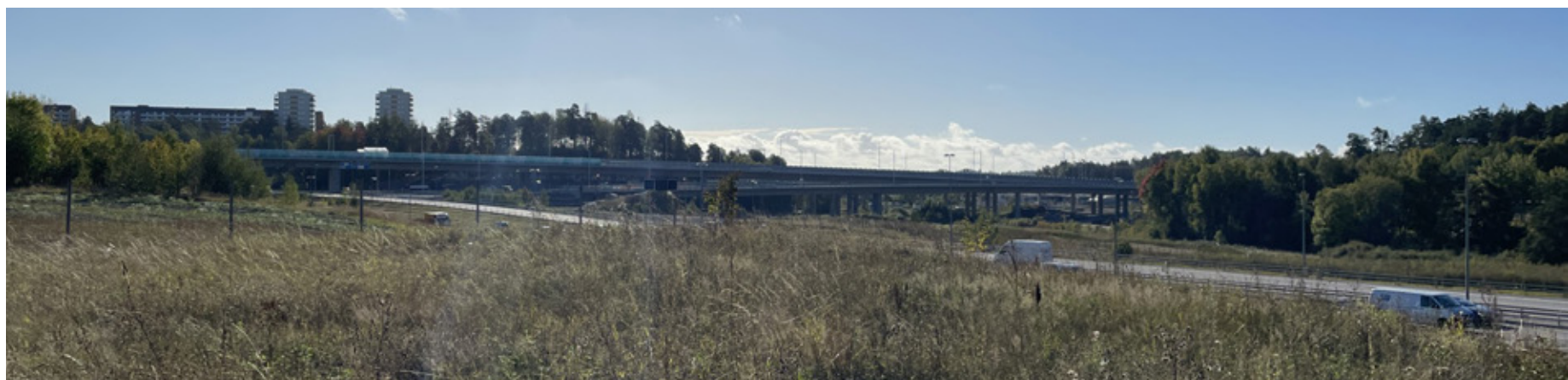
Figur 6. Vy mot Hjulsta trafikplats taget från gångbron. Höghusen på Hjulsta backar sticker tydligt upp i landskapet och brons transparent gröna bullerskydd.
