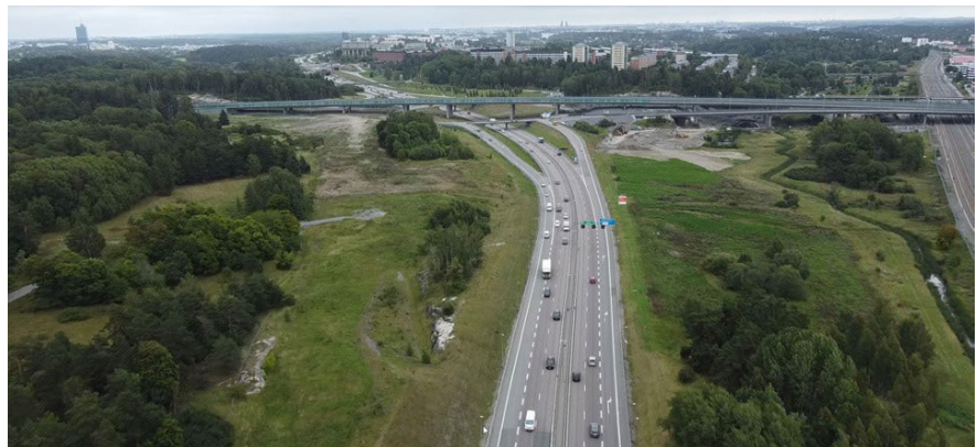
Vy österut mot Hjulsta trafikplats. Bild: Tyréns
