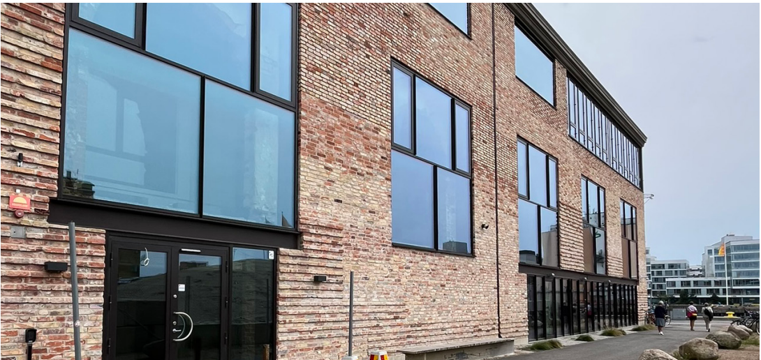
VARVSTADEN - GJUTERIET - KJELLANDER SJÖBERG - FASAD AV ÅTERBRUKAT TEGEL
