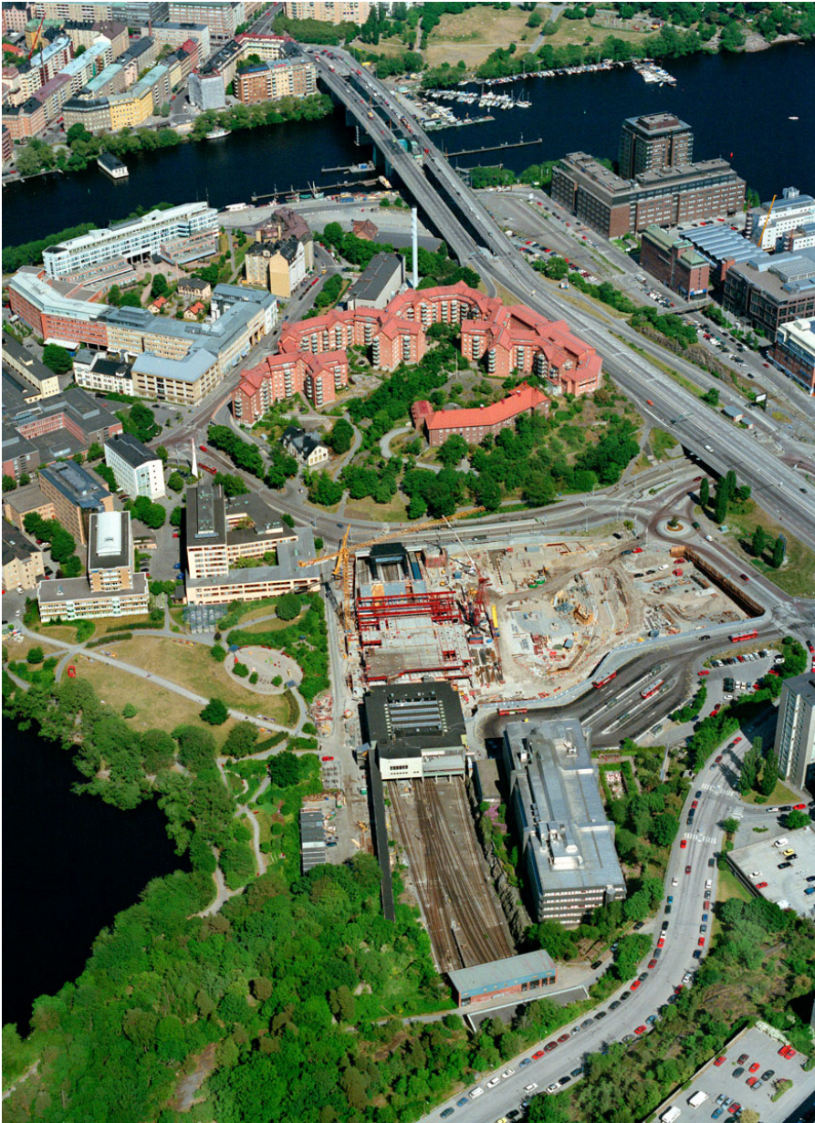
Flygbild över Liljeholmen och området kring tunnelbanestationen år 2001. De nya bostäderna i Kv Vänthallen är under uppförande på en överdäckning av tunnelbanespåren. Längre norrut syns det färdigställda bostadsområdet på Liljeholmsberget och kontorskomplexet i Kv Stora Katrineberg. Vänster om Kv Vänthallen syns den nyligen anlagda Trekantsparken som invigdes 1998. Foto: Nils-Åke Silversson
