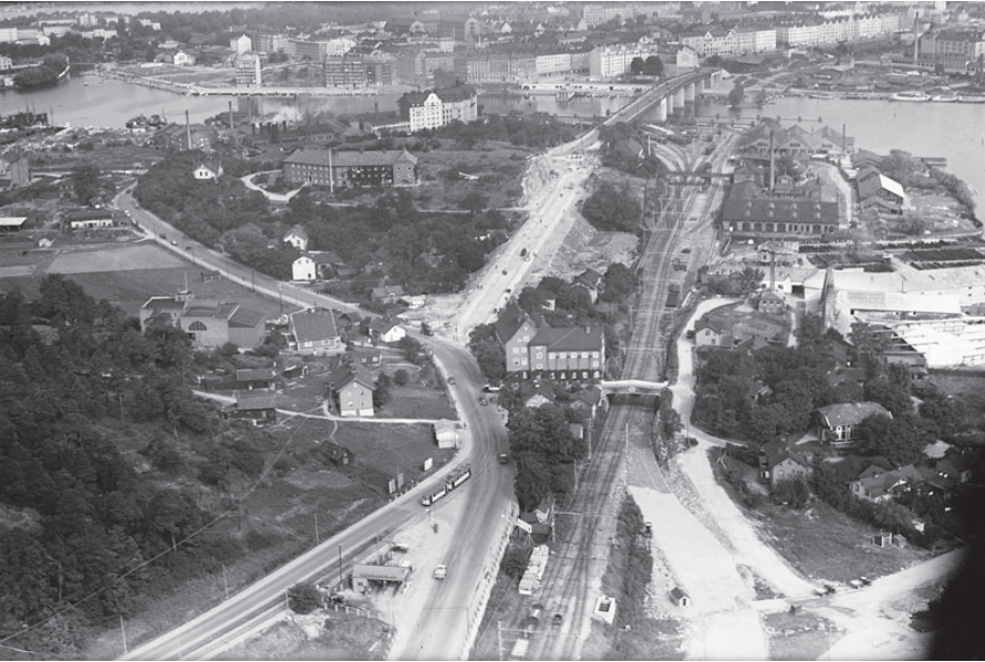
Flygfoto över Liljeholmen från söder år 1931-32, med nyligen anlagd infartsväg. Foto: O. Bladh.
