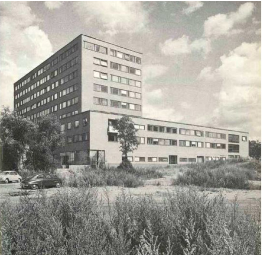
AB Atomenergis centralanläggning inom nuvarande Rosteriet 7, som övertogs av NUTEK år 1991 och därefter revs 2013. Foto ur tidskriften Arkitektur 1966. Källa: Stockholms stad
