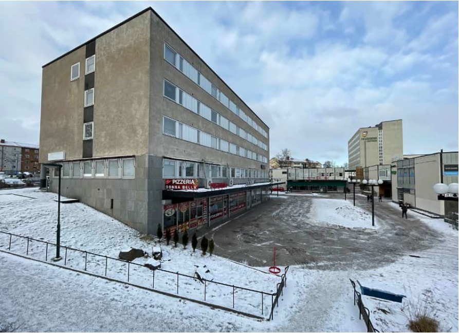
Dansösen 1 från sydöst med rampförbindelse till vänster.
