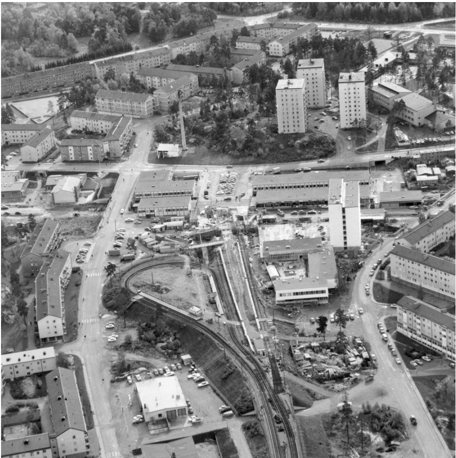
Flygfoto över Fruängen omkring 1963. Tunnelbanestationen är under uppförande. Stockholmskällan.
