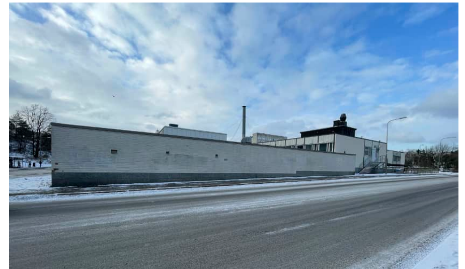
Guvernanten 1, lågdalens slutna fasad mot Ellen Keys gata. Härifrån syns också de skrymmande fläktrumsuppbyggnaderna på taken.
