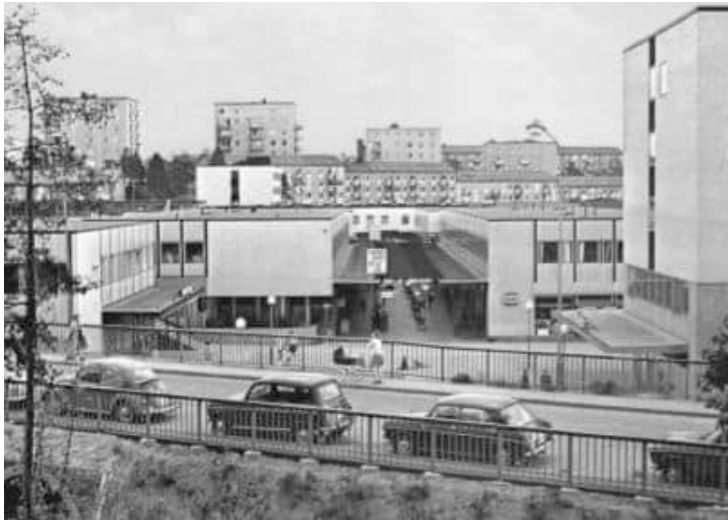
Den jämna byggnadshöjden i centrums kärna framgår tydligt liksom hur skärmtaken präglade centrummiljön. Inackorderingshemmet bortom butiksbyggnaderna framstår som mycket ljus. Kollektivt kulturarv.
