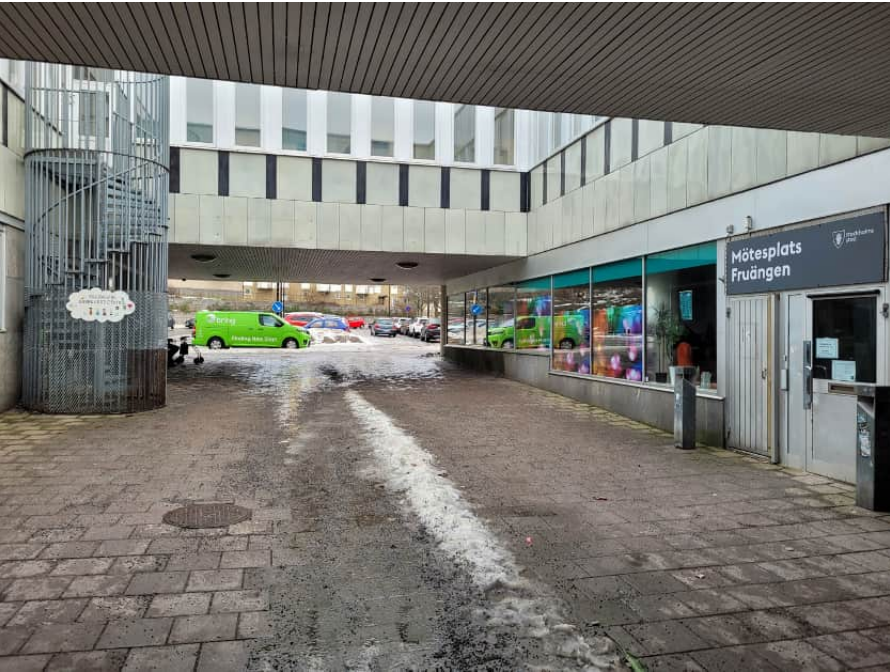
Fruängsgången genom Läkarcentralen i kv. Förkunnelsen. Marken är nu täckt av betongplattor i endast en kulör. En icke ursprunglig utrymningstrappa snävar i viss mån in utrymmet.
