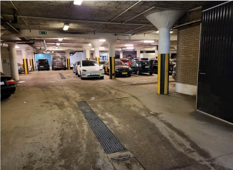
Parkerings- och verkstadsytor under mark i kv. Direktrisen har en för 1960-talet typisk utformning.
