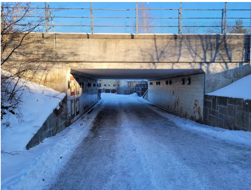
Gångpassage undre tunnelbanespåret sedd från infartsparkeringen. Ursprunglig keramik på väggarna.
