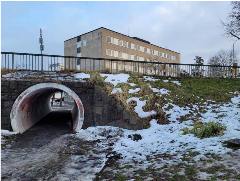
En av de två hästskoformade gångtunnlarna, här under Elsa Brändströms Gata med kv. Dansösen på andra sidan.
