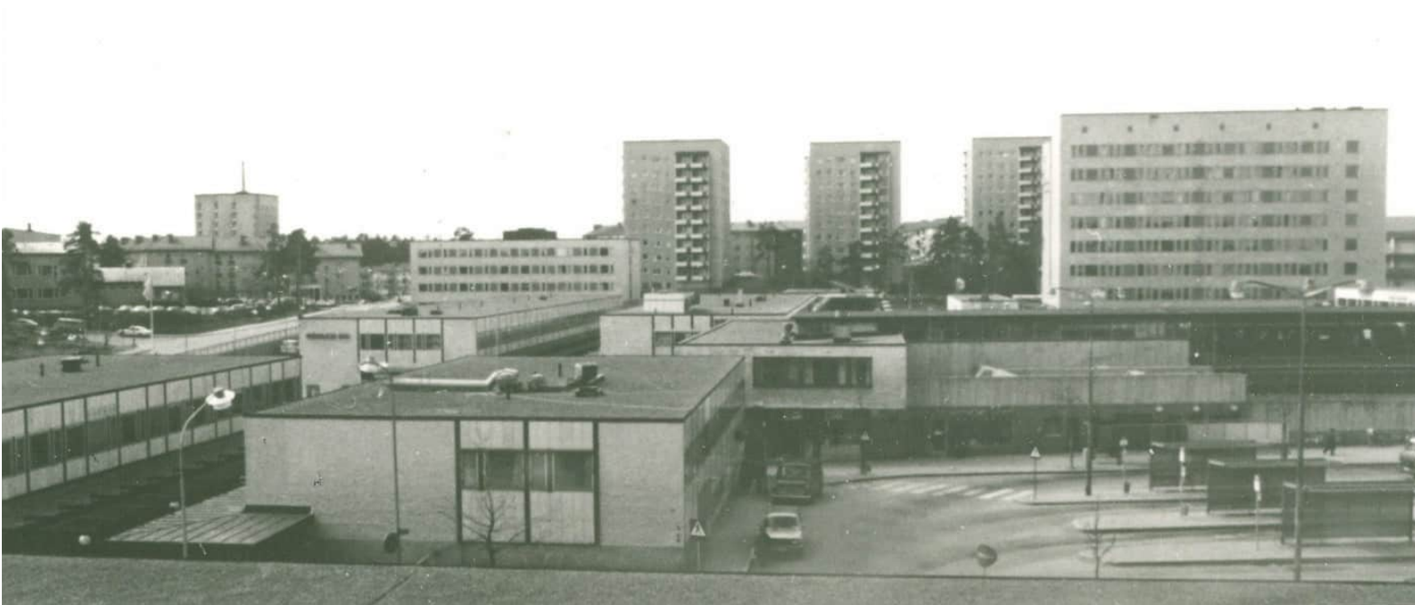
Centrum med busstationen år 1973. Punkthusen vid Eva Bonniers gata förstärker det rätvinkliga intrycket i centrum. Installationer har tillkommit på några av centrumbyggnadernas tak. Digitala Stadsmuseet.
