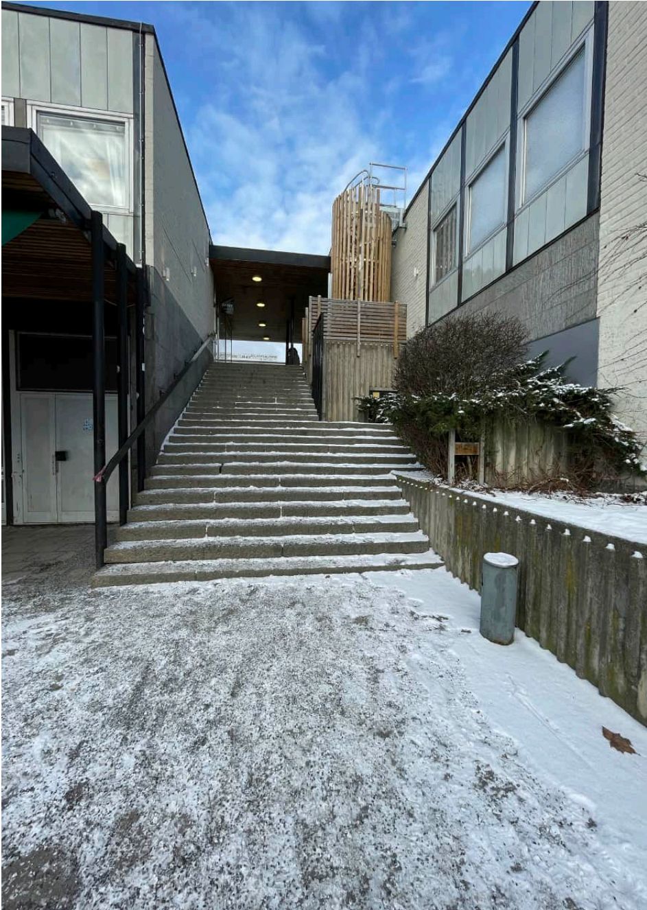
Trappförbindelsen i kv. Direktrisen med mönstergjuten betong runt planteringsytorna. Här bildar byggnader och utemiljö en starkt tidstypisk helhet. En utvändigt trappa för access till och utrymning från yttertaket har nyligen tillkommit och påverkar den ursprungliga strukturen negativt.
