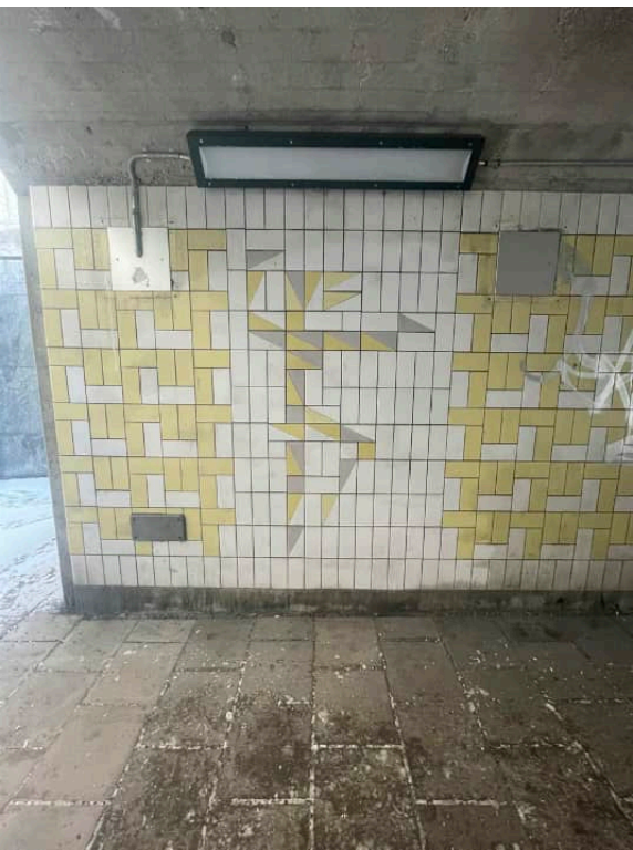
Den keramiska beklädnaden i Fruängsgången har en färgskala från 1950-talet och 1960-talets början. Miljöer som dessa kom några år senare att präglas av en mer rustik karaktär och dovare toner.
