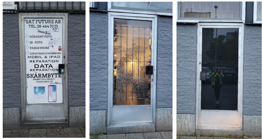
Ursprungliga dörrar på Ballerinan 1 mot söder. Foto Tyréns.
