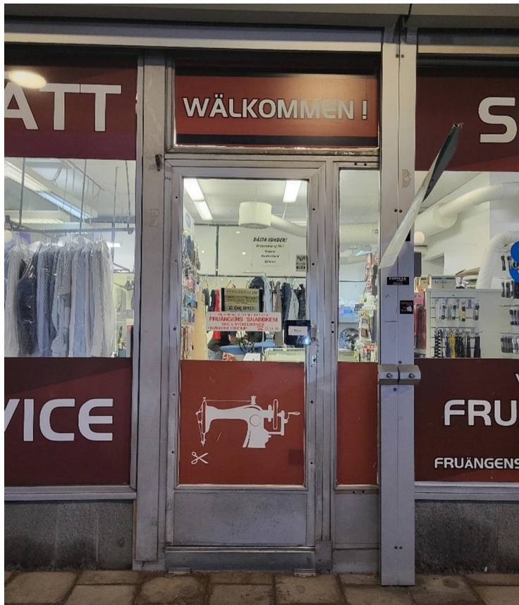
Figur 9 Entréparti med ursprunglig dörr samt sido- och överljus, Dansösen.
