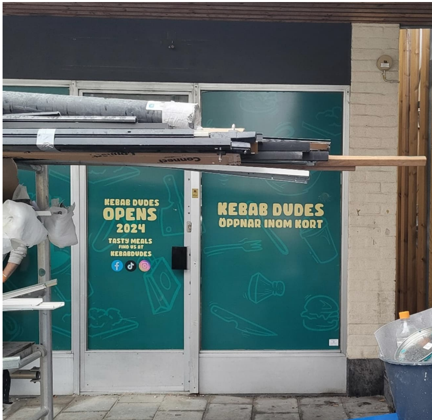
Figur 2 Ursprunglig dörr mot Fruängstorget, Direktrisen 1 hus A. Aluminiumprofilen på högra sidan av dörrbladet i bild är ersatt med ny i samma dimension som ursprungliga.
