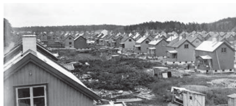
Enskedefältet under byggnad med Hemsbogen i fonden. Foto: Andersson 1932. SSM
