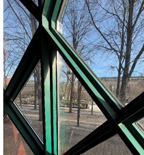
Invändiga glasprofiler av bockad plåt.
