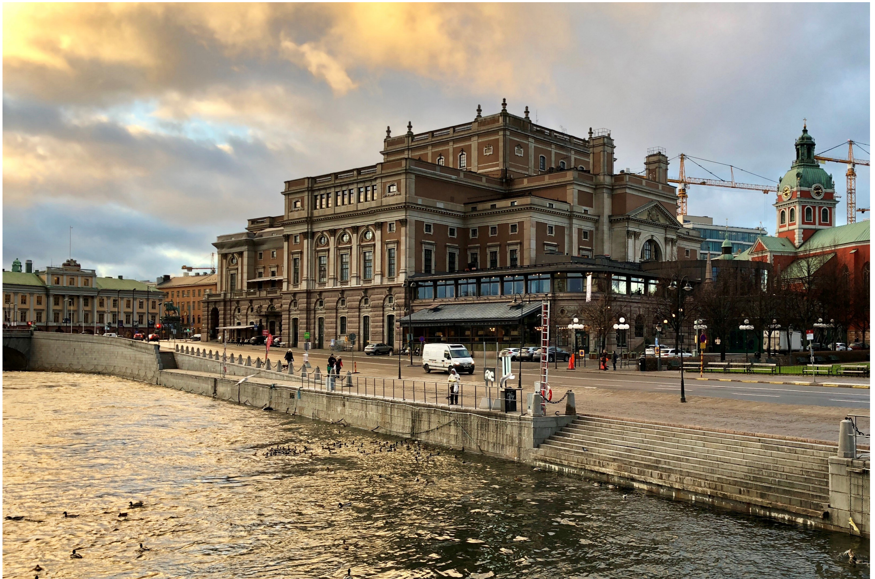
OPERABYGGNADEN SETT FRÅN STRÖMBRON, BEFINTLIG
