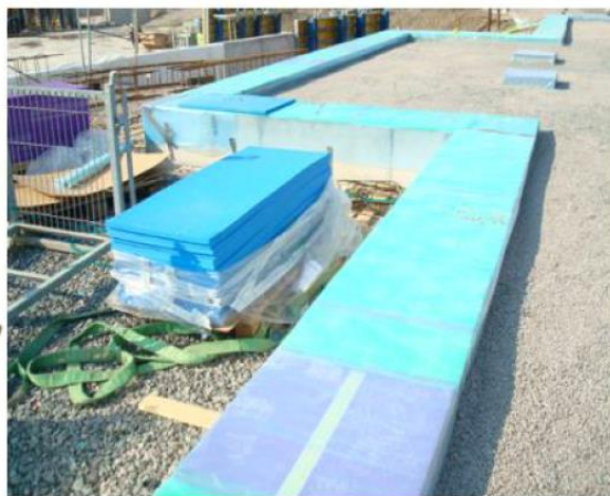
Figur 11. Exempel på vibrationsisolering av byggnad med gummiremsor (Källa: Christian Berner)
