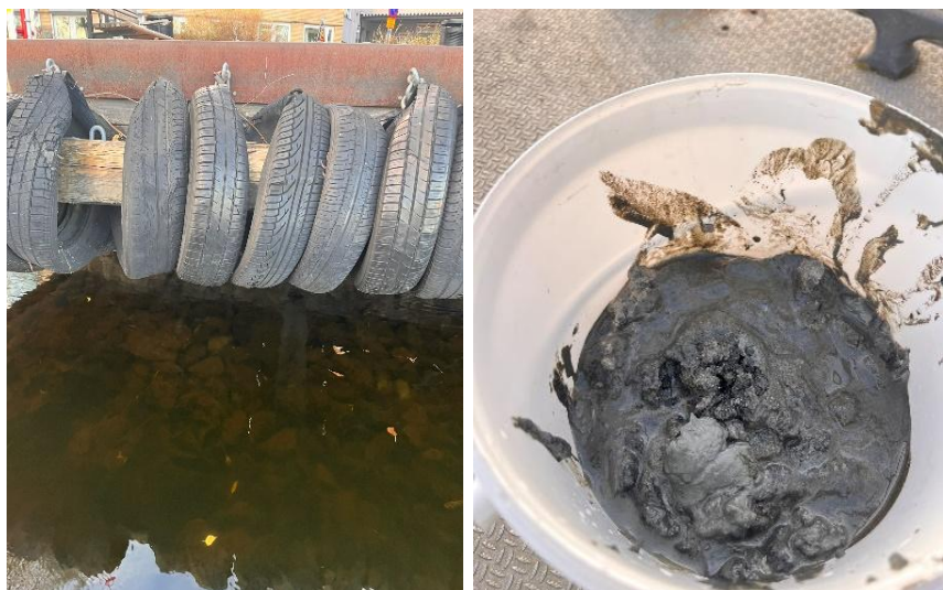
Figur 11. (Vänster) Synlig sprängsten på botten under brygga i södra området. (Höger) Exempel på hur sedimentet ser ut (gyttjig lerig grusig sand). Foton från (Viken miljökonsult, 2024).
